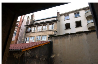
A droite, vue partielle de l'élévation postérieure depuis le 3e étage de l'immeuble accessible par le 5 rue Ferrandière (AE 53 sud) Phot. Véronique Belle IVR82_20046905354NUCA
