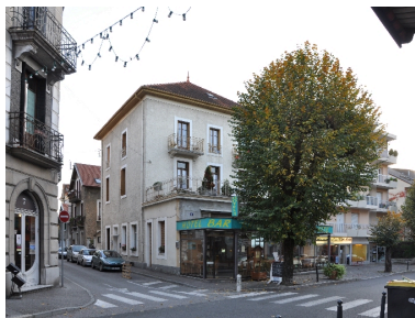
Vue d'ensemble Phot. François Fouger IVR82_20097301080NUCA
