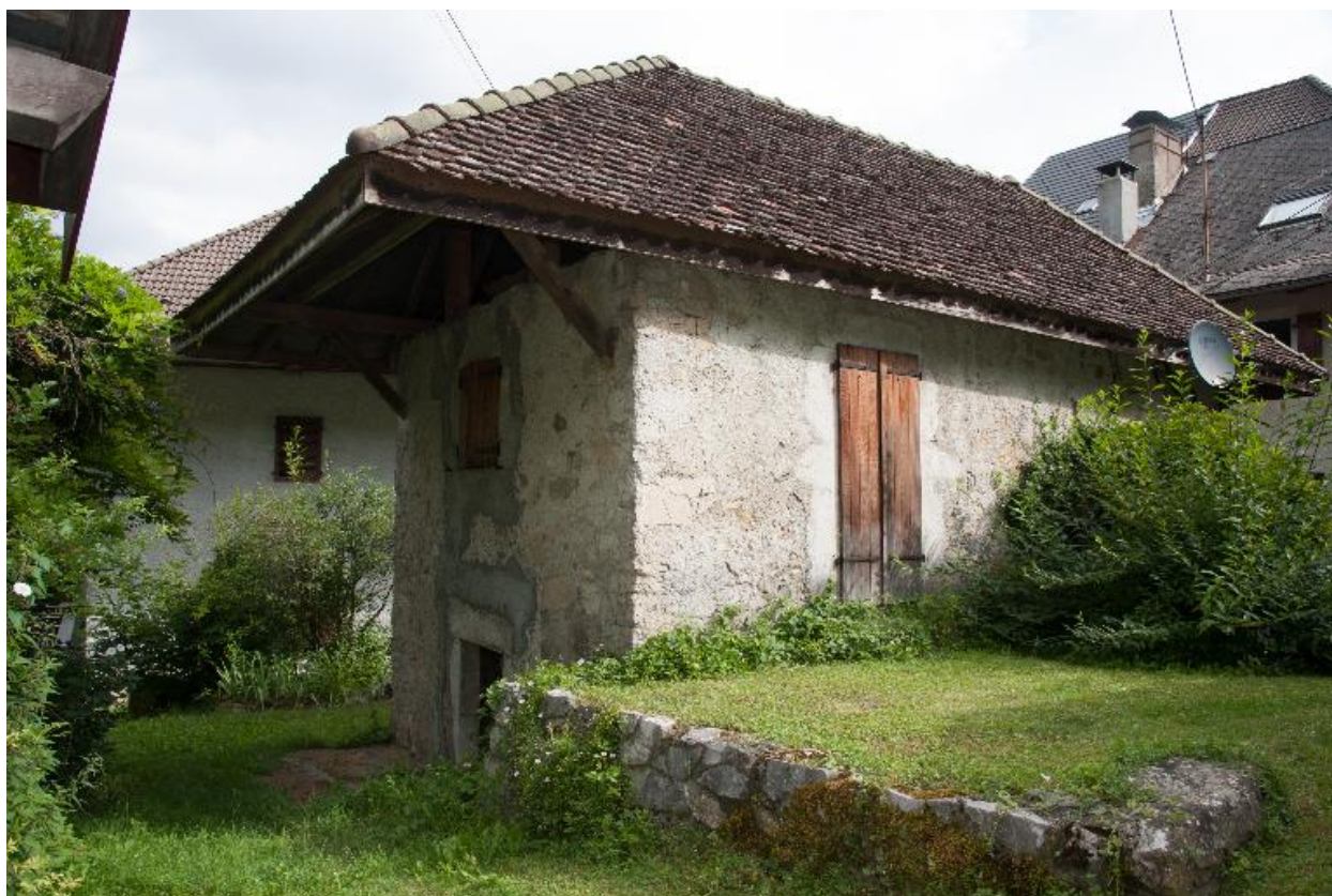
Vue de la façade arrière du grenier.
