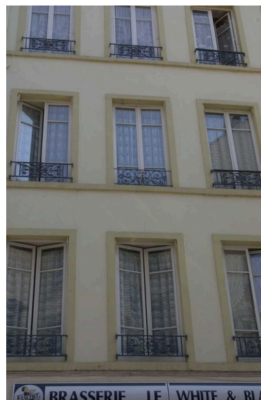
Détail des fenêtres Phot. Coralie Belleville IVR82_20026902959NUCA
