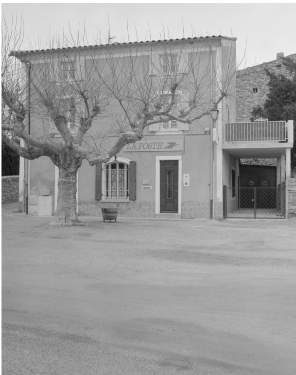
Vue de l'élévation principale de la poste, ancienne maison commune (collectif maisons : A1 192).
