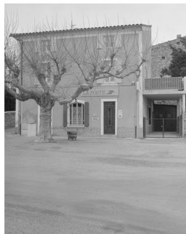
Vue de l'élévation principale de la poste, ancienne maison commune (collectif maisons : A1 192). Phot. Alain Franchella IVR82_19982601083X
