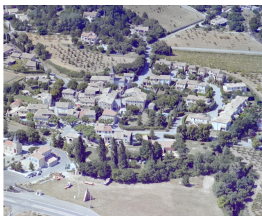
Vue aérienne depuis le sud. Phot. Alain Franchella IVR82_20002601322XE
