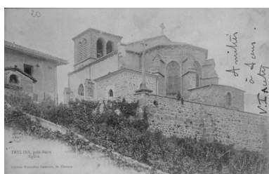
Trelins, près Boën / Eglise. Edition Nouvelles Galeries, phot. Nancy A.B. & Cie". [1903, tampon de la poste], vue d'ensemble du chevet de l'église et de la croix de cimetière. Repro. Eric Dessert, Autr. Nancy (photographe) A. B. & Cie IVR82_20014200357XB
