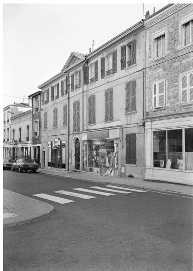
Façade sur rue. Phot. Jean-Marie Refflé IVR82_19900100316P
