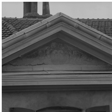
Détail du chiffre en médaillon dans le fronton. Phot. Jean-Marie Refflé IVR82_19910100887X
