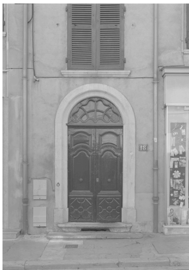
Porte d'entrée sur rue. Phot. Jean-Marie Refflé IVR82_19900100317P
