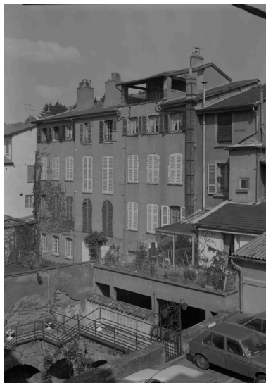
Elévation sur jardin, vue d'ensemble. Phot. Jean-Marie Refflé IVR82_19910100480P
