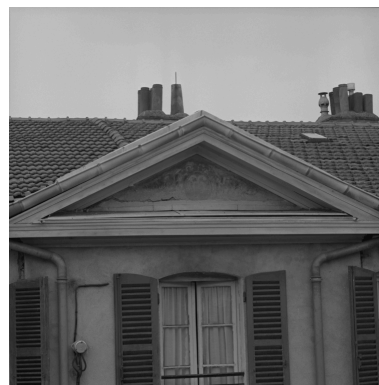
Façade sur rue, fronton avec chiffre peint. Phot. Jean-Marie Refflé IVR82_19910100886X
