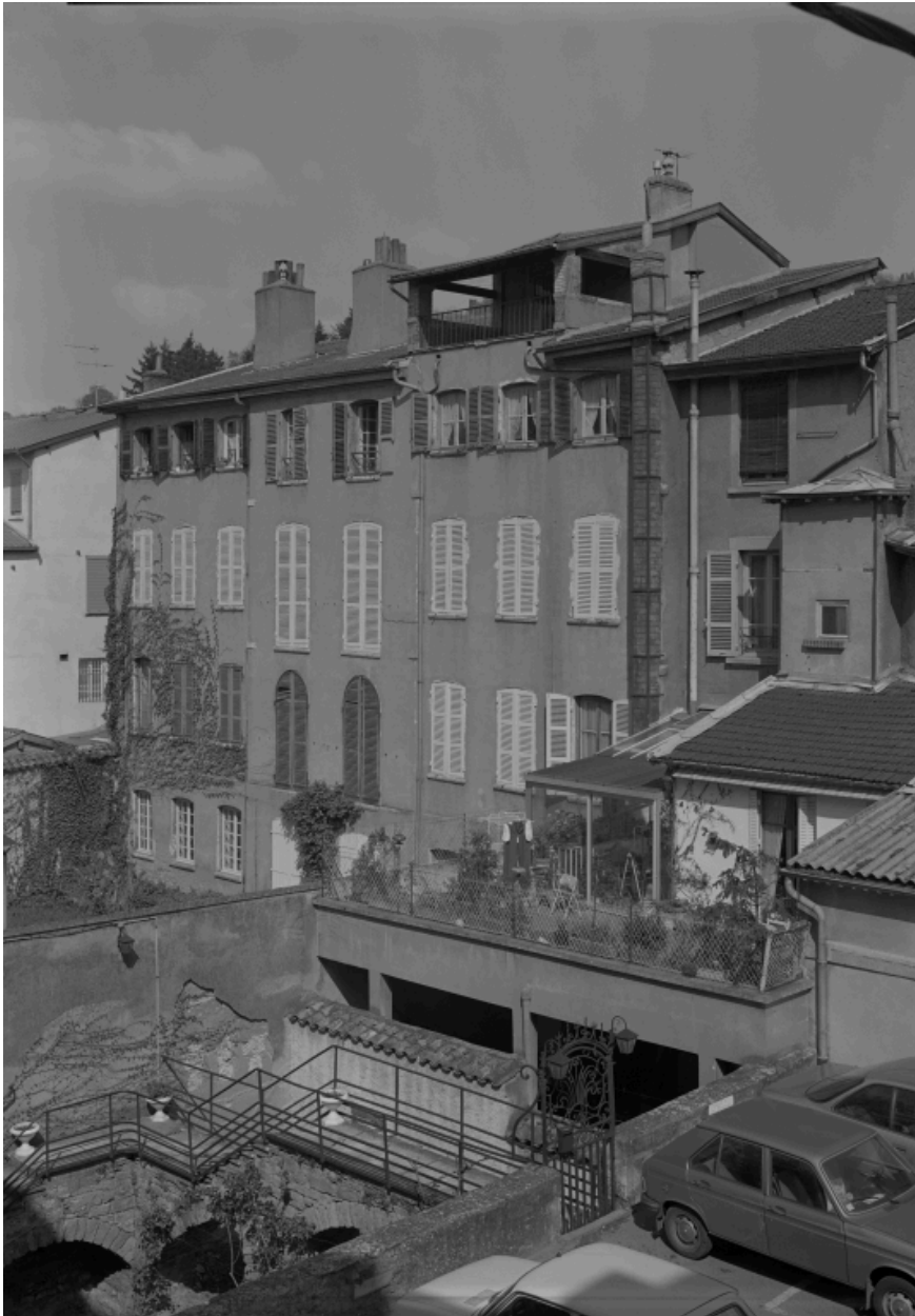
Elévation sur jardin, vue d'ensemble.
