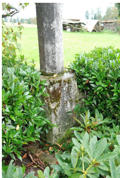
Détail de la base de la croix.
