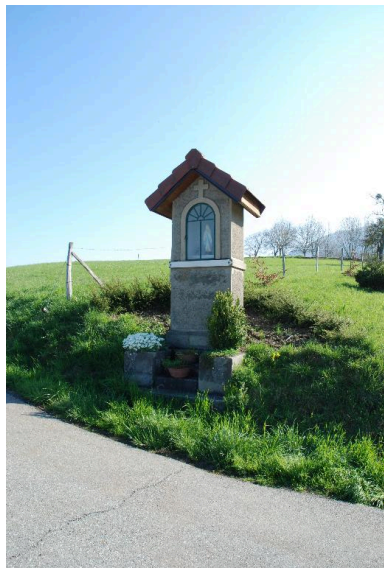
Vue d'ensemble. Phot. Caroline Guibaud IVR82_20147302191NUCA
