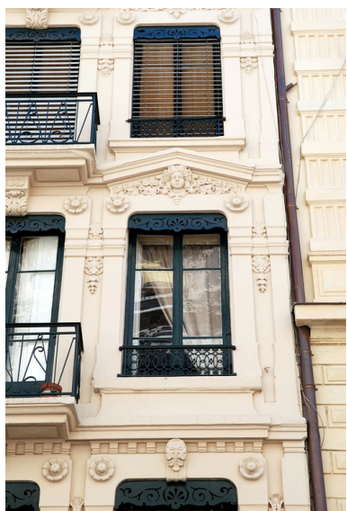
Elévation antérieure : ornementation d'une fenêtre du deuxième étage carré Phot. Véronique Belle IVR82_20096904659NUCA
