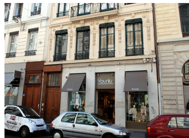
Elévation antérieure : le rez-de-chaussée Phot. Véronique Belle IVR82_20096904656NUCA
