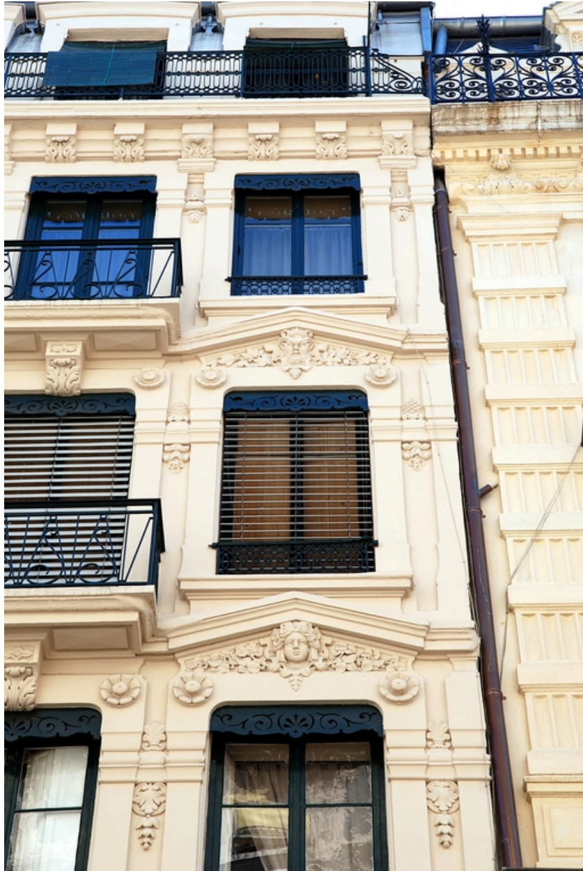
Elévation antérieure : vue partielle
