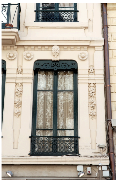
Elévation antérieure : détail d'une baie du premier étage carré et de la signature de l'architecte Phot. Véronique Belle IVR82_20096904658NUCA
