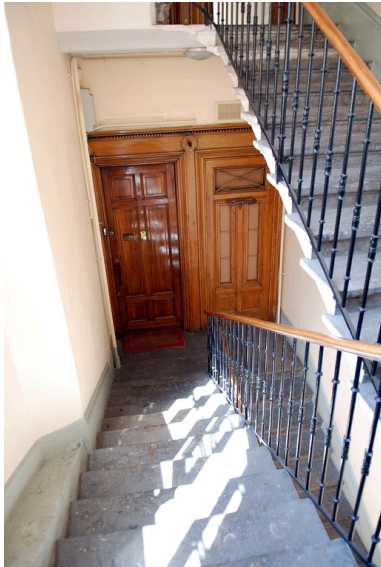
Escalier et portes palières Phot. Véronique Belle IVR82_20096904662NUCA
