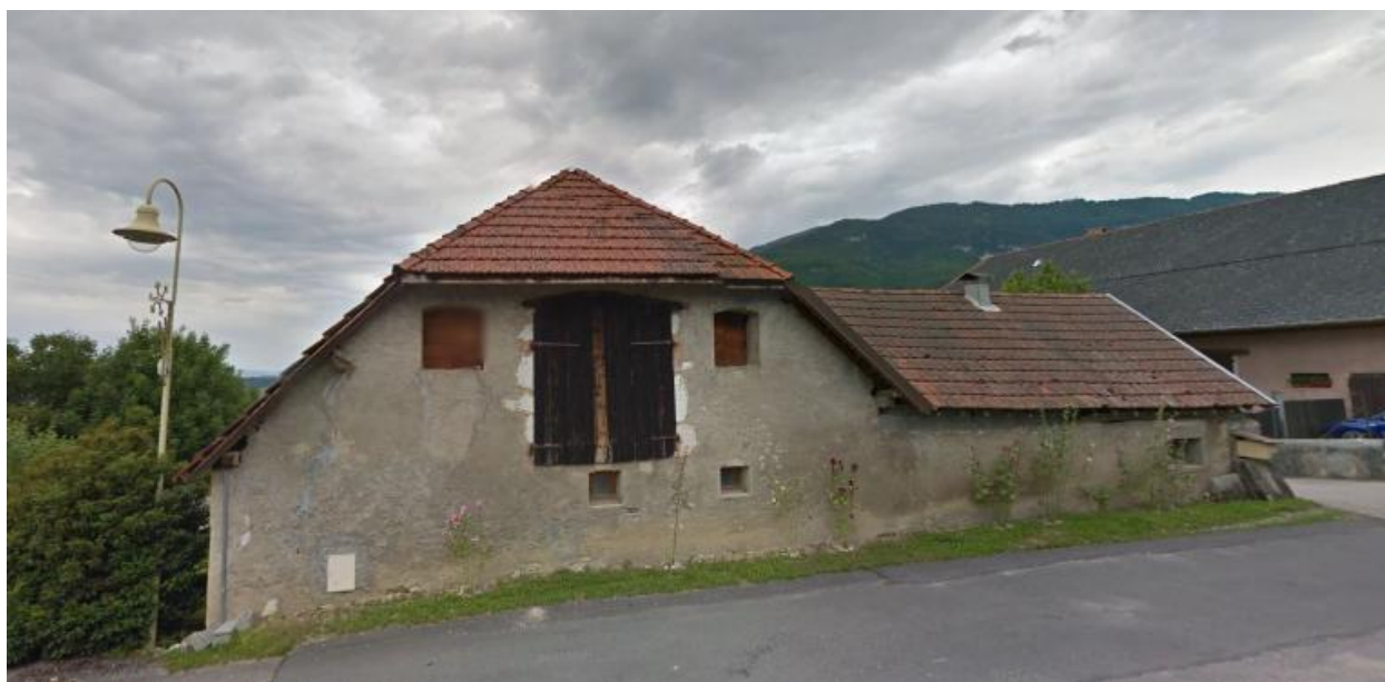
Vue d'ensemble du pignon sud. Photo Google Maps.
