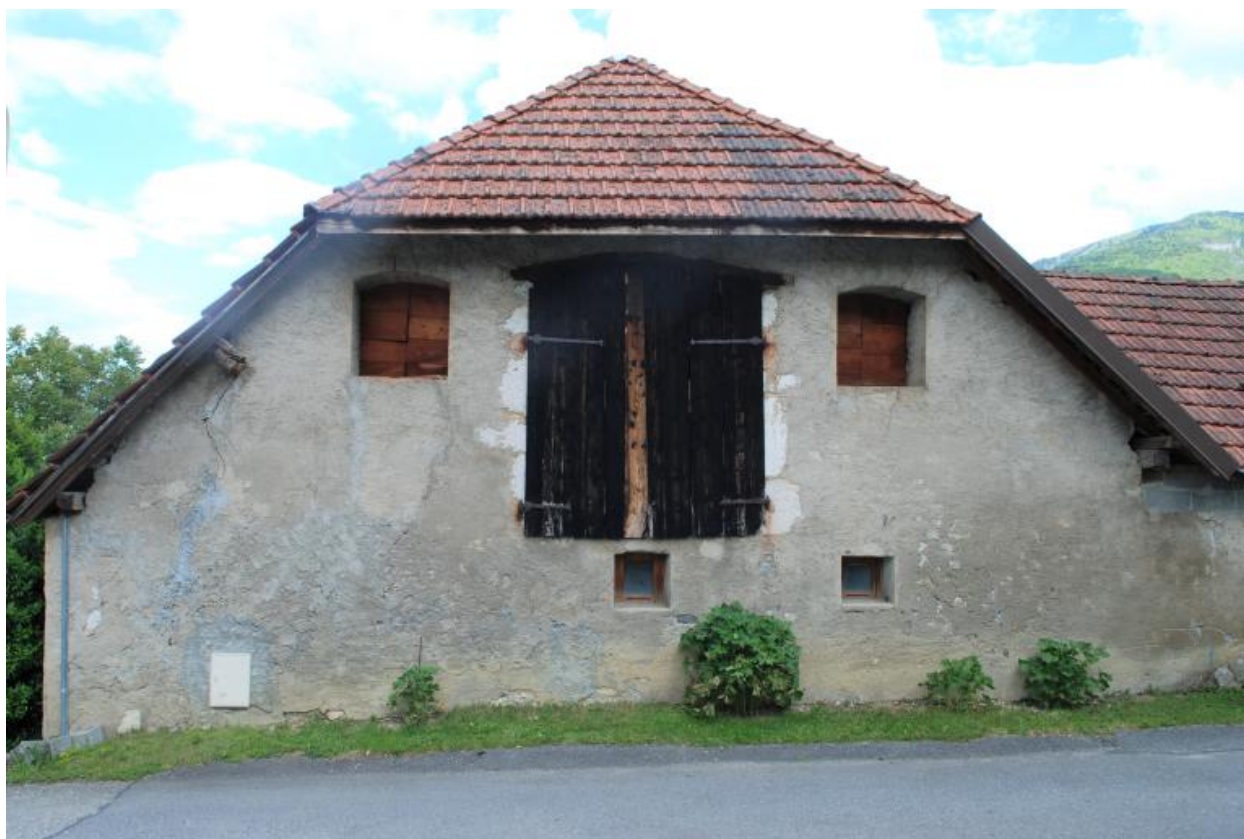
Vue d'ensemble du mur pignon sud.
