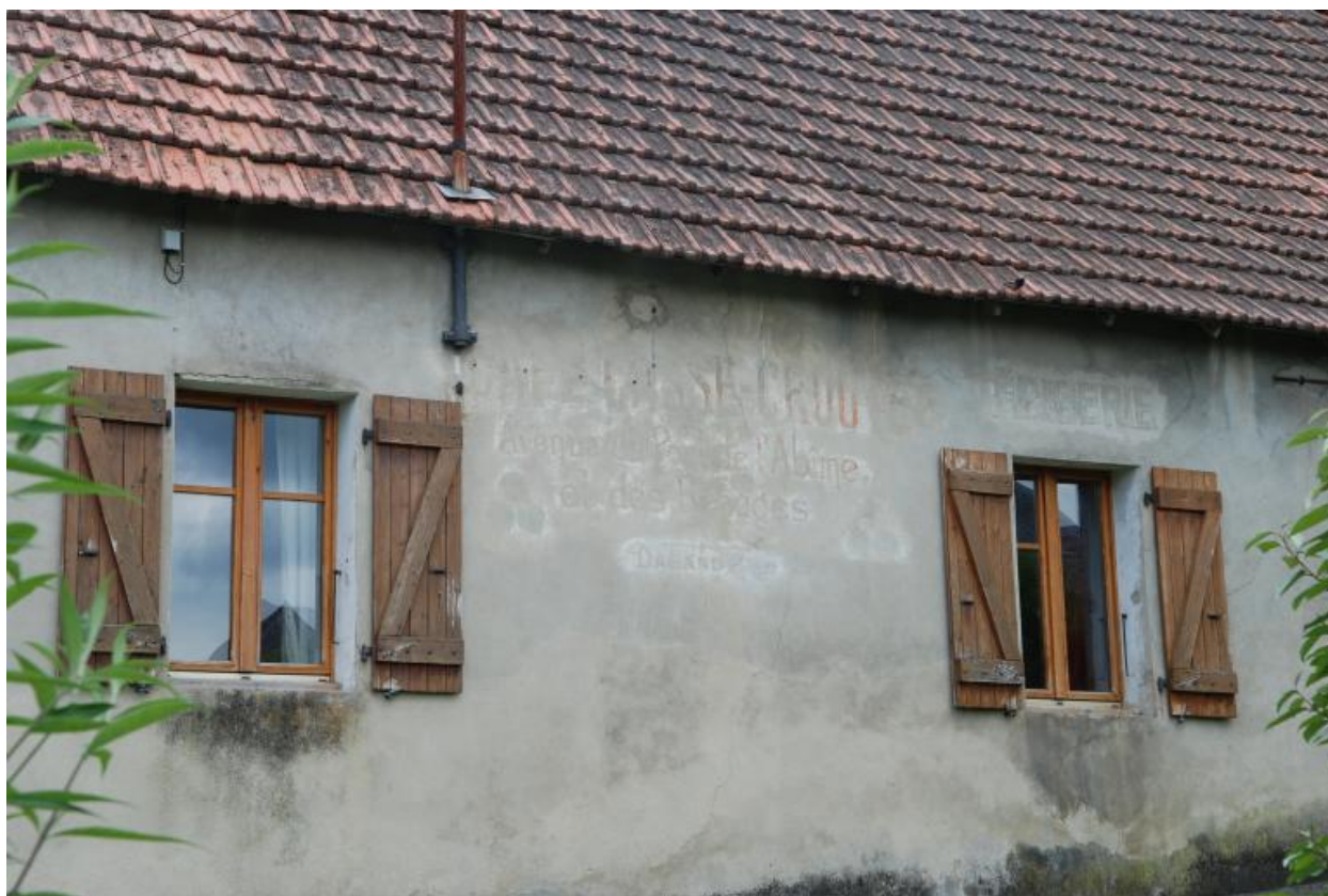
Détail des baies de la façade ouest avec inscriptions peintes.
