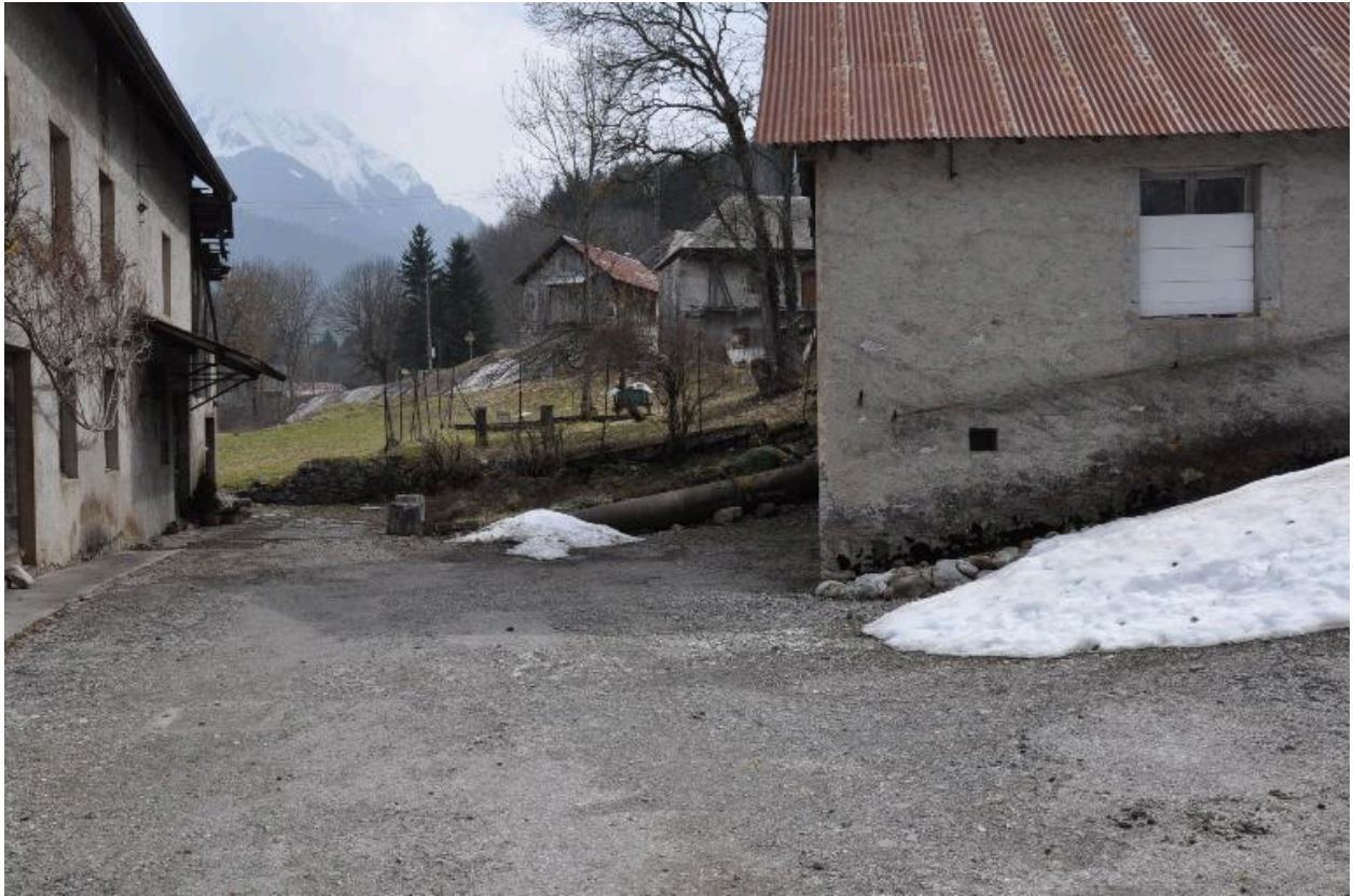
Vue de la conduite forcée.
