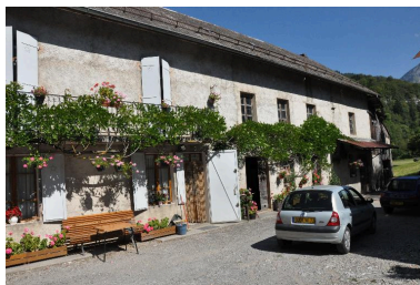
Vue du bâtiment datant des années 1930 : à gauche la partie habitation, à droite la partie moulin. Phot. Clara Bérelle IVR82_20137301607NUCA
