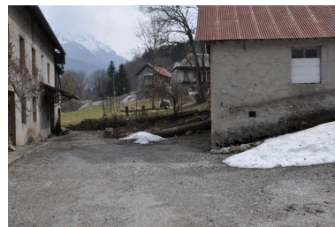
Vue de la conduite forcée. Phot. Clara Bérelle IVR82_20137301608NUCA
