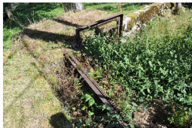
Eléments de vannage au départ de la conduite forcée. Phot. Clara Bérelle IVR82_20137301609NUCA
