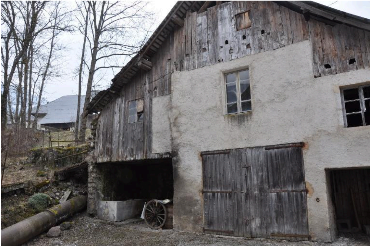
Façade nord du moulin d'origine.
