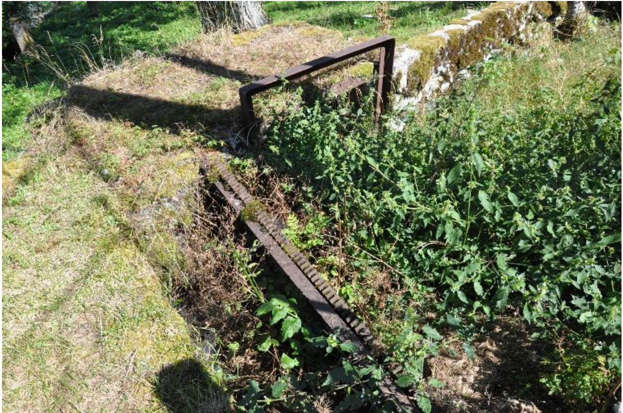
Éléments de vannage au départ de la conduite forcée.
