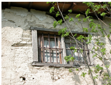
Détail d'une fenêtre de l'étage de l'habitation sud des communs, côté sud. Phot. Caroline Guibaud IVR82_20134202950NUCA
