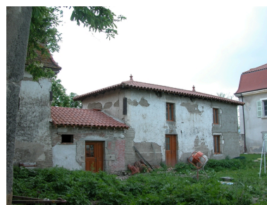
Vue d'ensemble du bâtiment sud des communs, depuis l'avant-cour. Phot. Caroline Guibaud IVR82_20134202939NUCA
