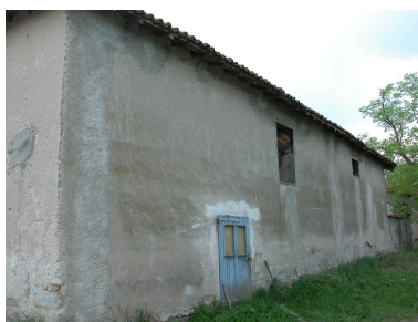
Vue de l'élévation nord de la grange-étable. Phot. Caroline Guibaud IVR82_20134202944NUCA
