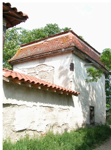
Vue du pigeonnier et du bâtiment sud des communs, depuis le sud-ouest. Phot. Caroline Guibaud IVR82_20134202949NUCA
