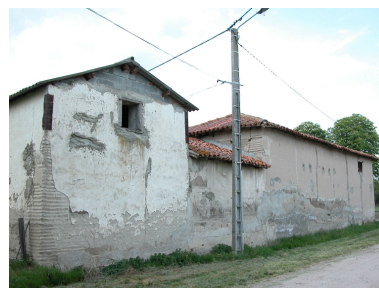
Vue de la ferme, depuis le sud-est. Phot. Caroline Guibaud IVR82_20134202943NUCA
