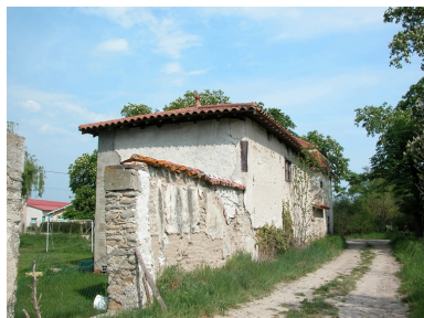
Vue d'ensemble du bâtiment sud des communs, depuis l'ouest. Phot. Caroline Guibaud IVR82_20134202952NUCA
