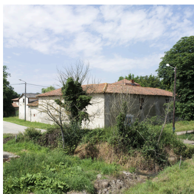
Vue générale de la ferme, depuis le nord-est. Phot. Didier Gourbin IVR82_20074200093NUCA
