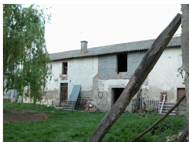
Vue du bâtiment entre communs et ferme, depuis l'avant-cour. Phot. Caroline Guibaud IVR82_20134202941NUCA
