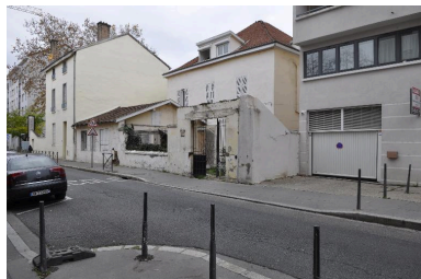
Vue de situation Phot. Magali Delavenne IVR82_20156902724NUCA
