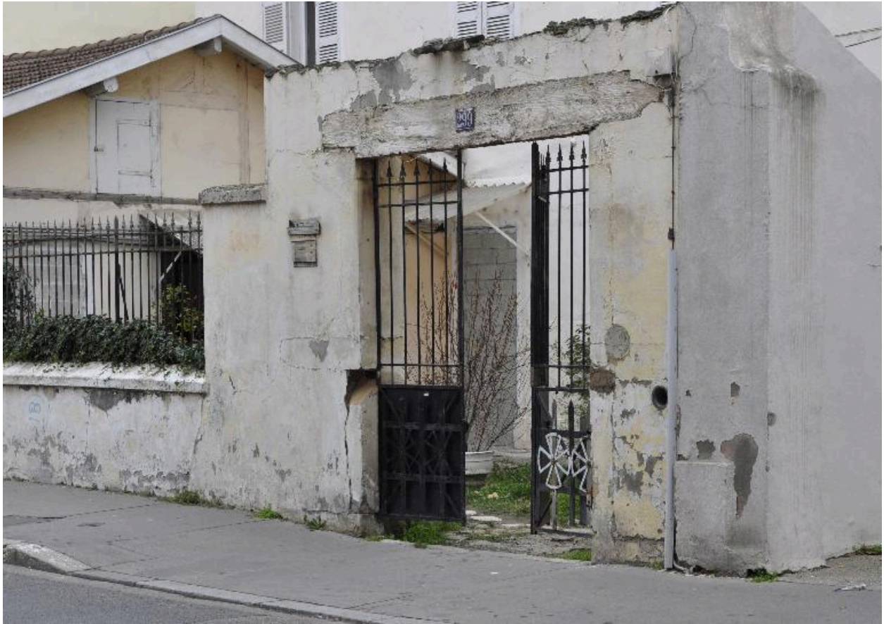
Détail du portail à linteau en bois
