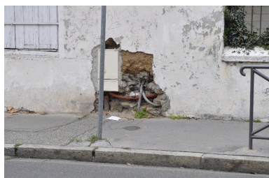
Détail du pisé de la remise Phot. Magali Delavenne IVR82_20156902728NUCA
