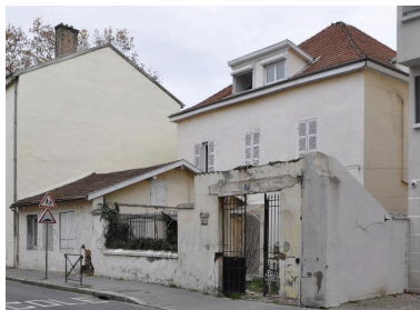
Vue d'ensemble Phot. Magali Delavenne IVR82_20156902687NUCA
