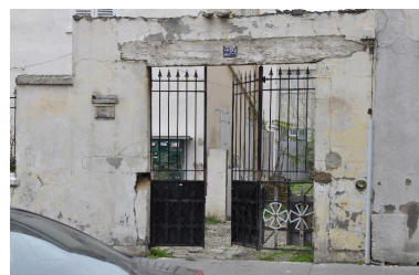
Détail du portail Phot. Magali Delavenne IVR82_20156902727NUCA
