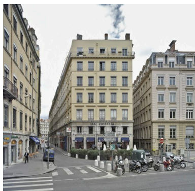
La rue de l'Ancienne-Préfecture depuis le quai des Célestins. A droite, la rue du Port-du-Temple Phot. Eric Dessert IVR82_20076902481NUCA
