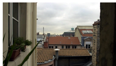
Toitures du quartier depuis l'escalier de l'immeuble 6 rue de l'Ancienne-Préfecture Phot. Véronique Belle IVR82_20076901245NUCA
