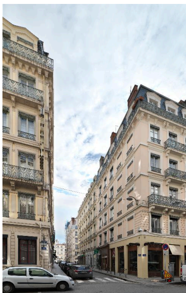
La rue Simon-Maupin, rive sud Phot. Eric Dessert IVR84_20176900439NUCA
