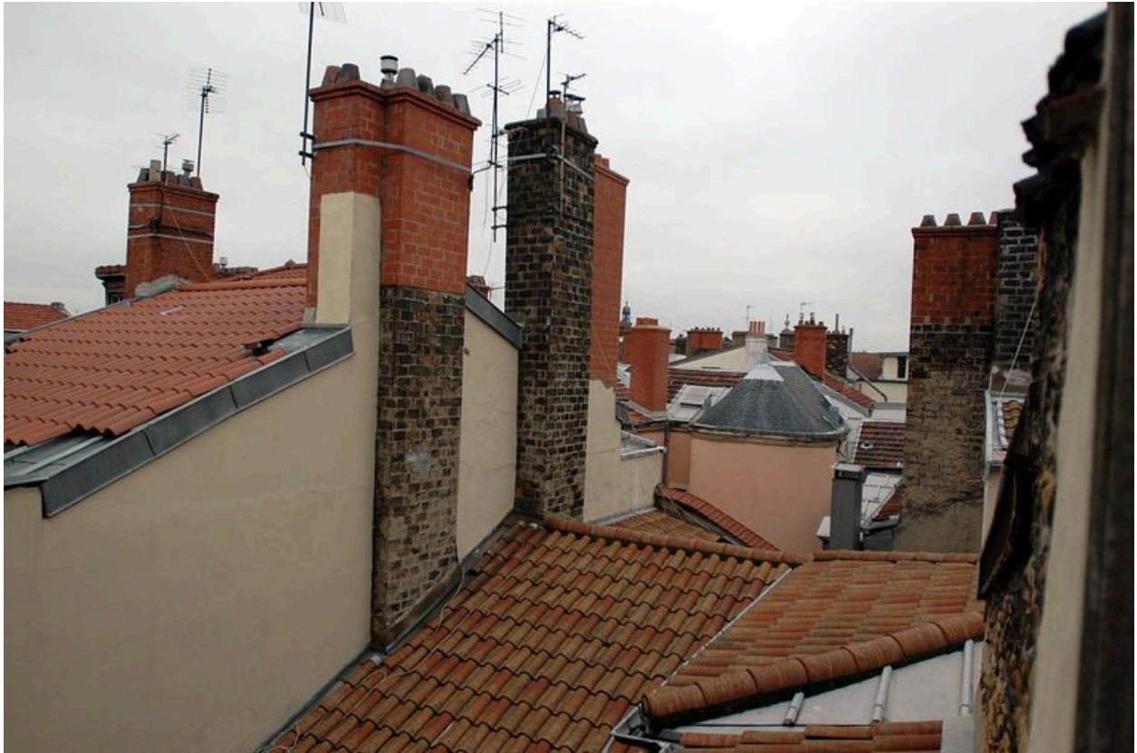
Toitures du quartier depuis l'immeuble sis 6 rue Thomassin
