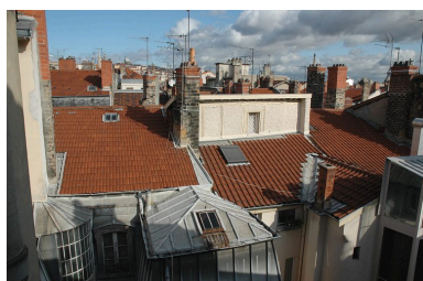
Toitures du quartier depuis l'escalier de l'immeuble sis 5 rue Thomassin Phot. Véronique Belle IVR82_20086902910NUCA
