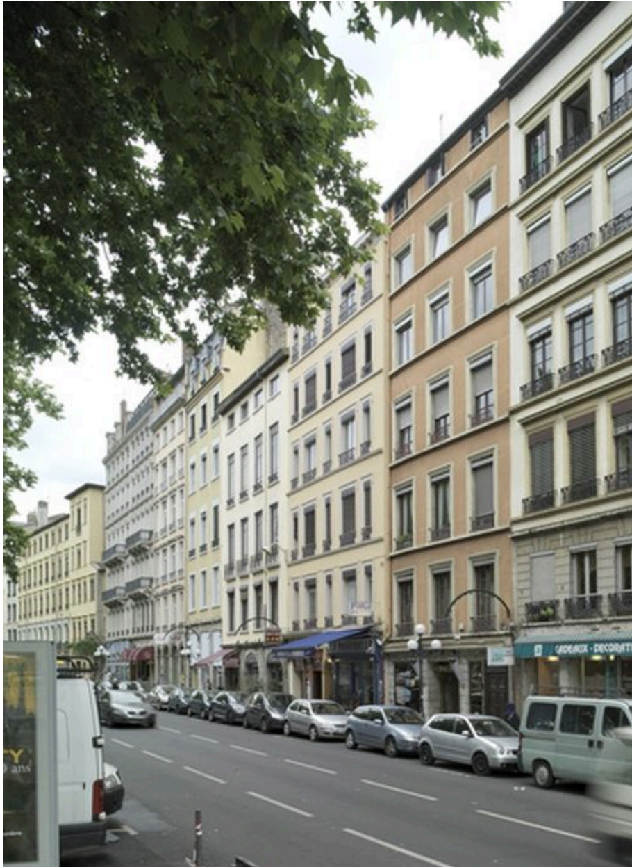
Partie sud du quai Saint-Antoine
