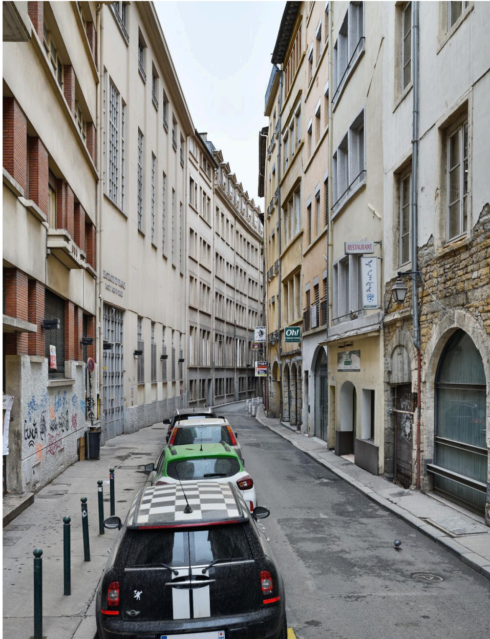
La rue du port-du-Temple depuis l'est
