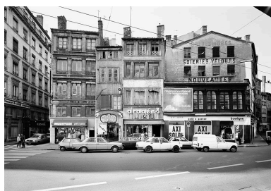
Immeubles, 56 et 58 rue de Brest, état en 1982 Repro. Jean-Marie Refflé IVR82_19826900029P
