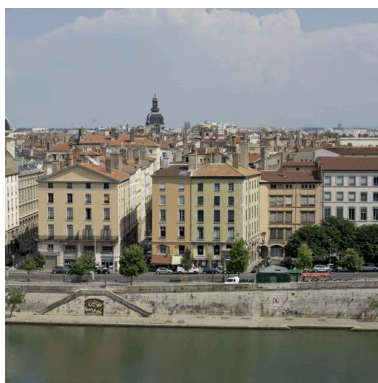
Quai des Célestins : vue partielle depuis la toiture de la cathédrale Saint-Jean Phot. Eric Dessert IVR82_20066900557NUCA
