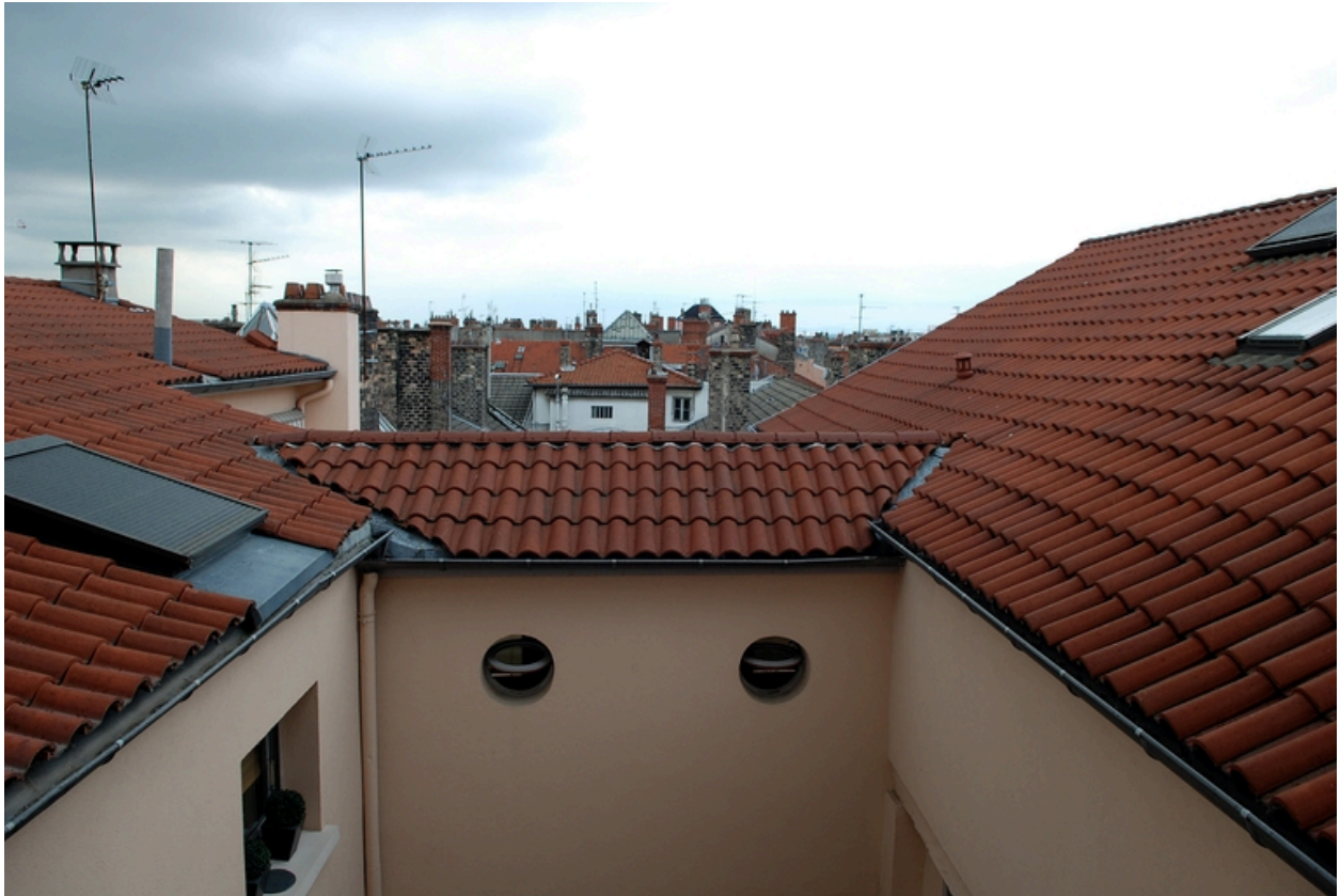
Toitures du quartier depuis l'escalier de l'immeuble sis 8 place des Jacobins
