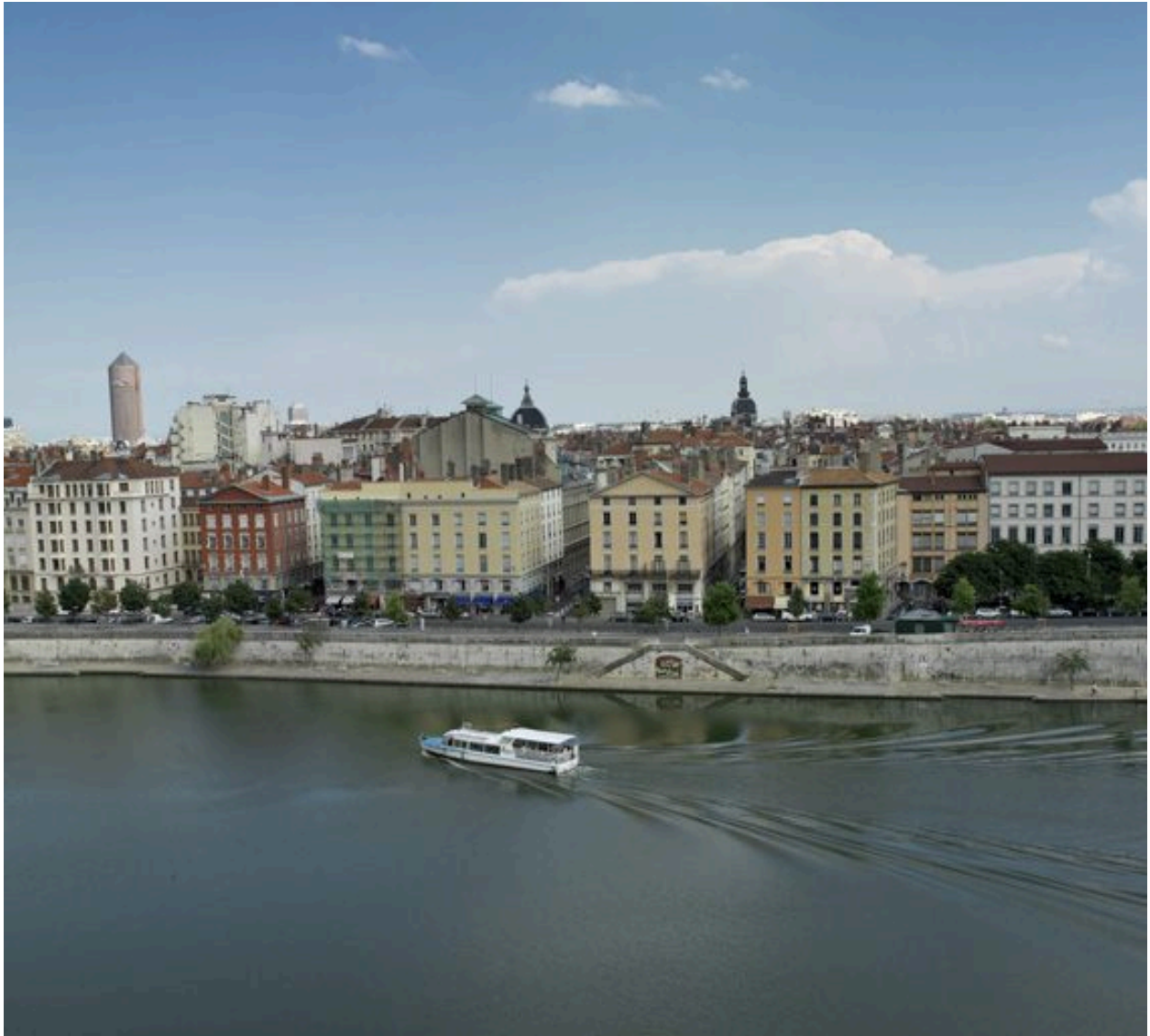
Quai des Célestins : la partie sud depuis la toiture de la cathédrale Saint-Jean
