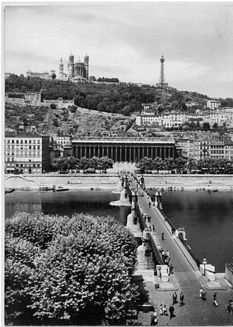
Jonction de la passerelle du Palais de Justice, du quai Saint-Antoine et du quai des Célestins
