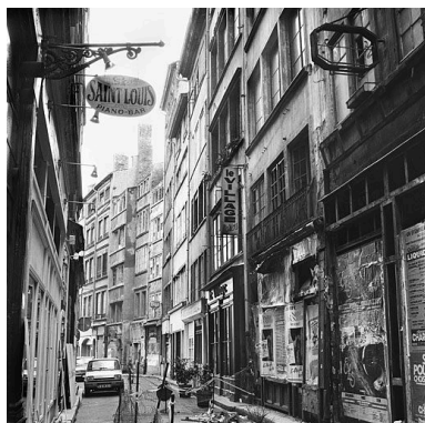
La rue Mercière depuis le n°70, état en 1982 Phot. Jean-Marie Refflé IVR82_19826900005X
