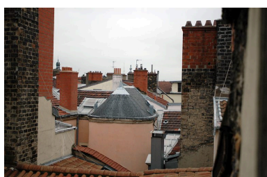
Toitures du quartier depuis l'immeuble sis 6 rue Thomassin Phot. Véronique Belle IVR82_20086902956NUCA
