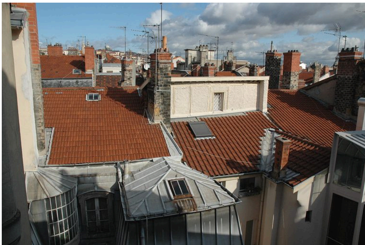
Toitures du quartier depuis l'escalier de l'immeuble sis 5 rue Thomassin
