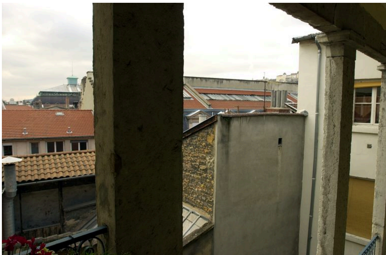
Toitures du quartier depuis l'escalier de l'immeuble 6 rue de l'Ancienne-Préfecture
