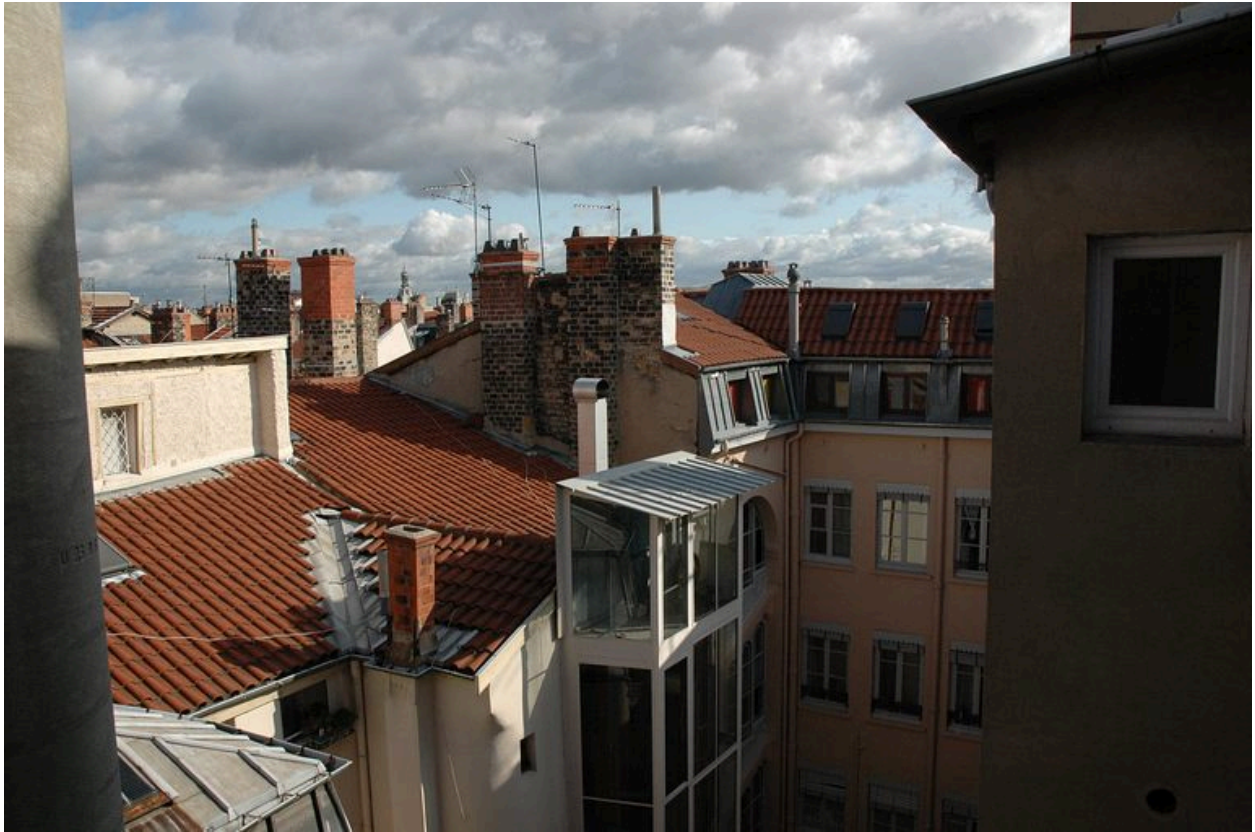
Toitures du quartier depuis l'immeuble sis 5 rue Thomassin
