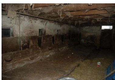
Vue intérieure de l'étable. Phot. Thierry Monnet IVR84_20167304612NUCA
