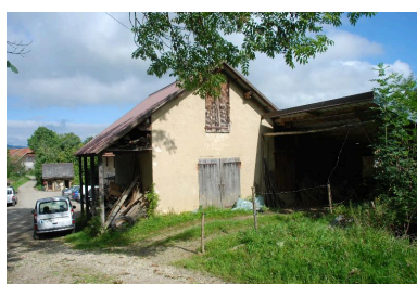
Vue du logement sur cave, depuis l'est. Phot. Thierry Monnet IVR84_20167304611NUCA
