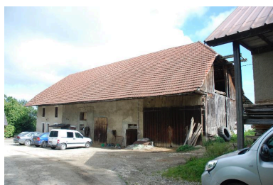
Vue d'ensemble. Phot. Thierry Monnet IVR84_20167304608NUCA
