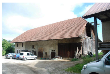
Vue d'ensemble. Phot. Thierry Monnet IVR84_20167304608NUCA
