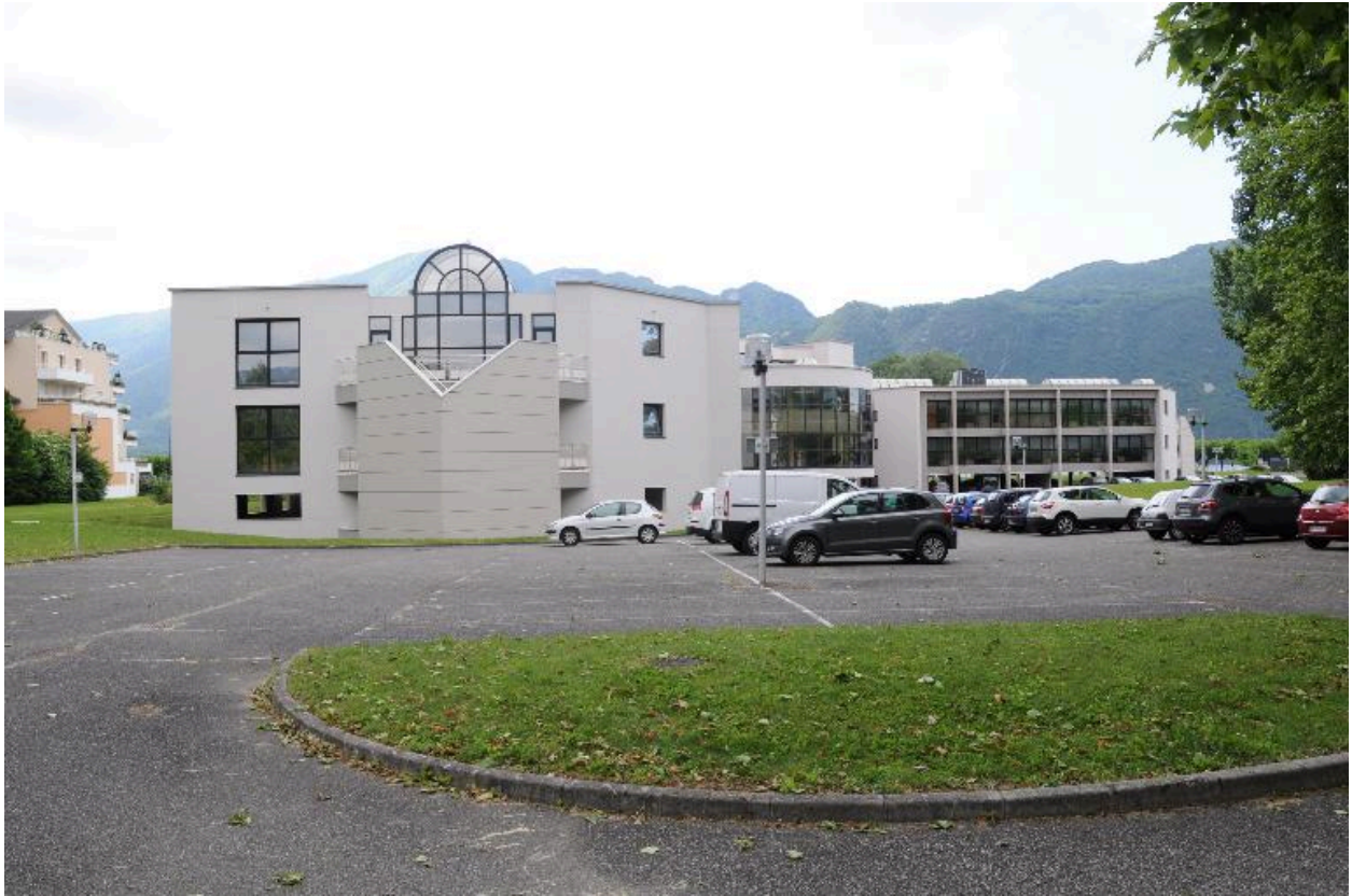
Vue depuis l'arrière
