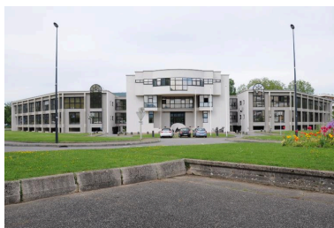
Vue d'ensemble Phot. Denys Harreau IVR82_20157300811NUCA
