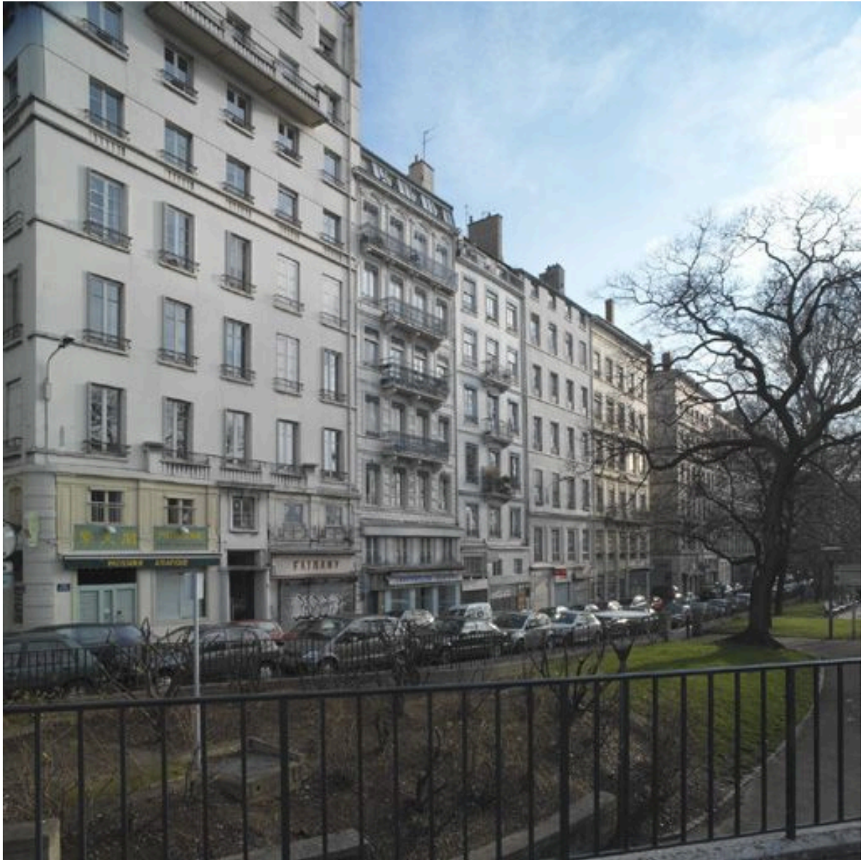
Vue des immeubles formant le front de place aux n°4-8, place Raspail
