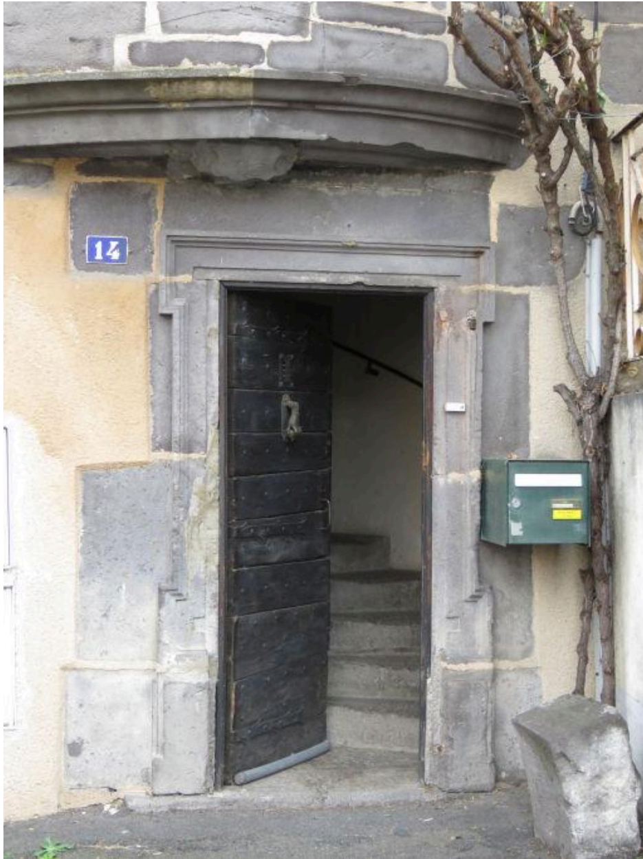
Vue de détail : porte d'entrée
