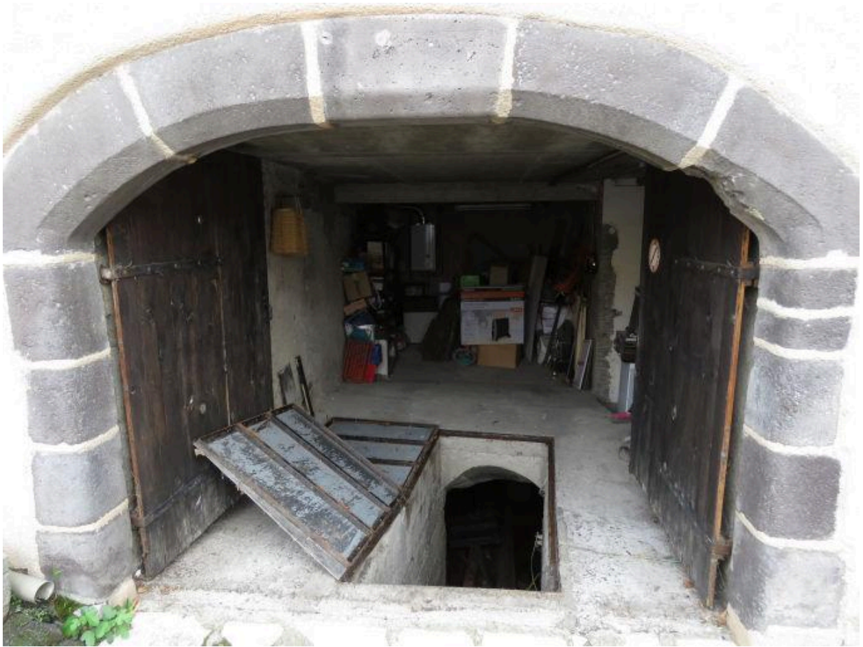
Vue de détail : entrées du cuvage et du chai enterré
