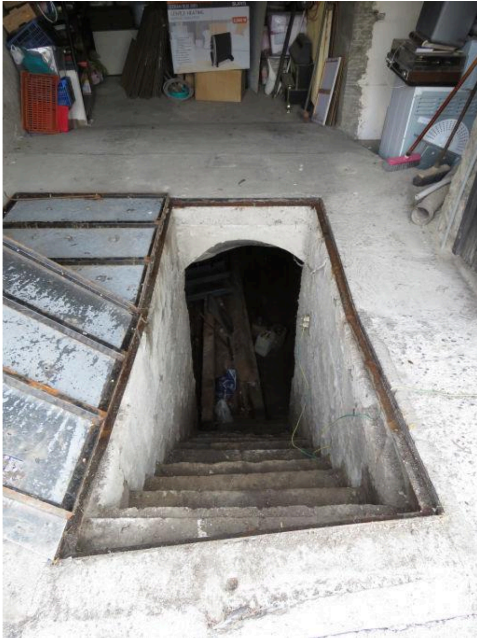
Vue de détail : entrée et escalier menant au sous-sol
