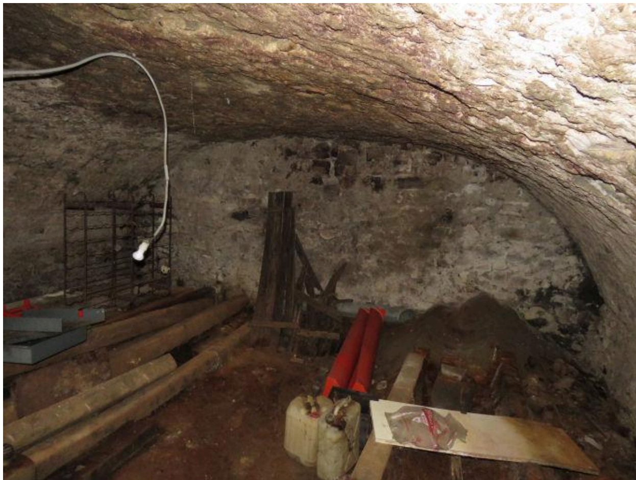
Vue intérieure : chai
