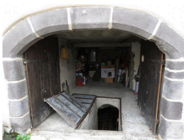
Vue de détail : entrées du cuveage et du chai enterré Phot. Bruno Decrock IVR84_20216300081NUCA
