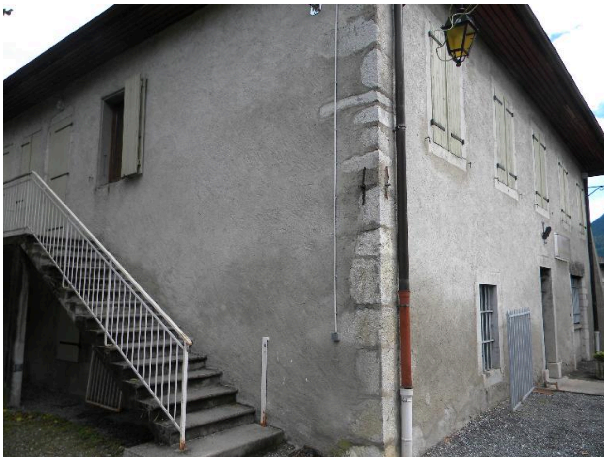
Vue de trois-quarts sud-ouest.
