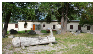
Façade ouest sur le Forum Phot. Jean-François Lyon-Caen IVR82_20127302384NUCA
