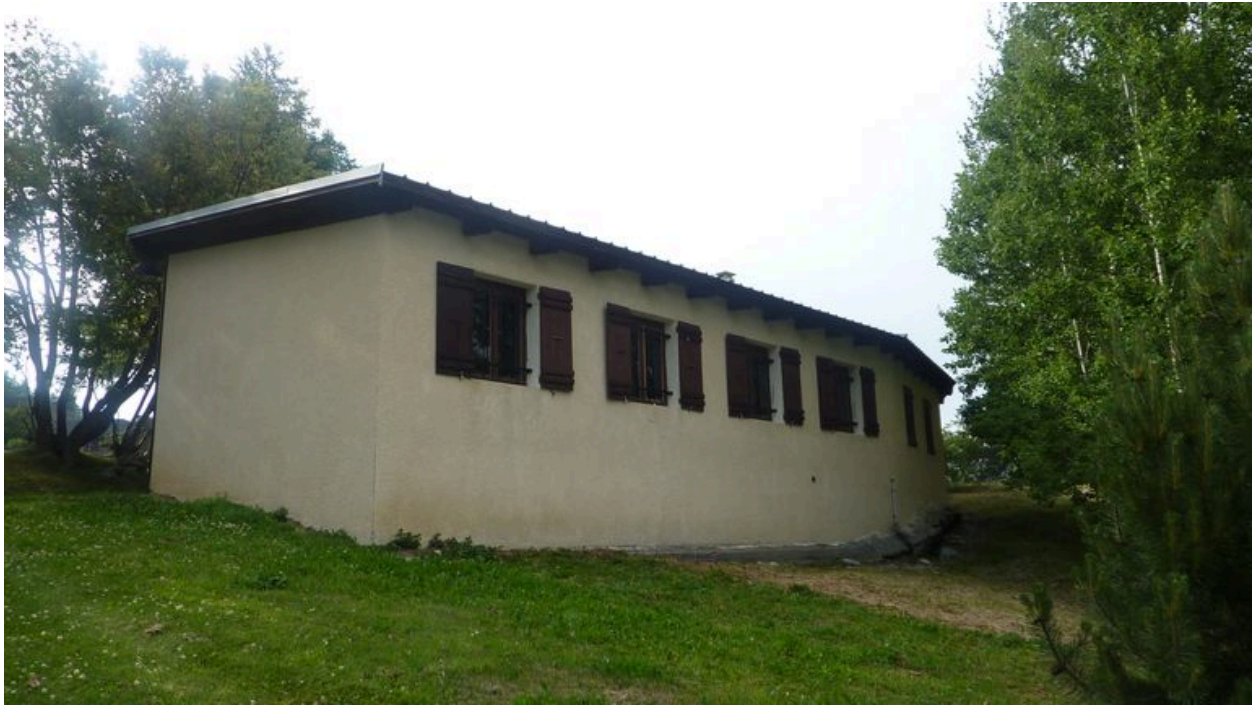
Elévation postérieure depuis le sud-est
