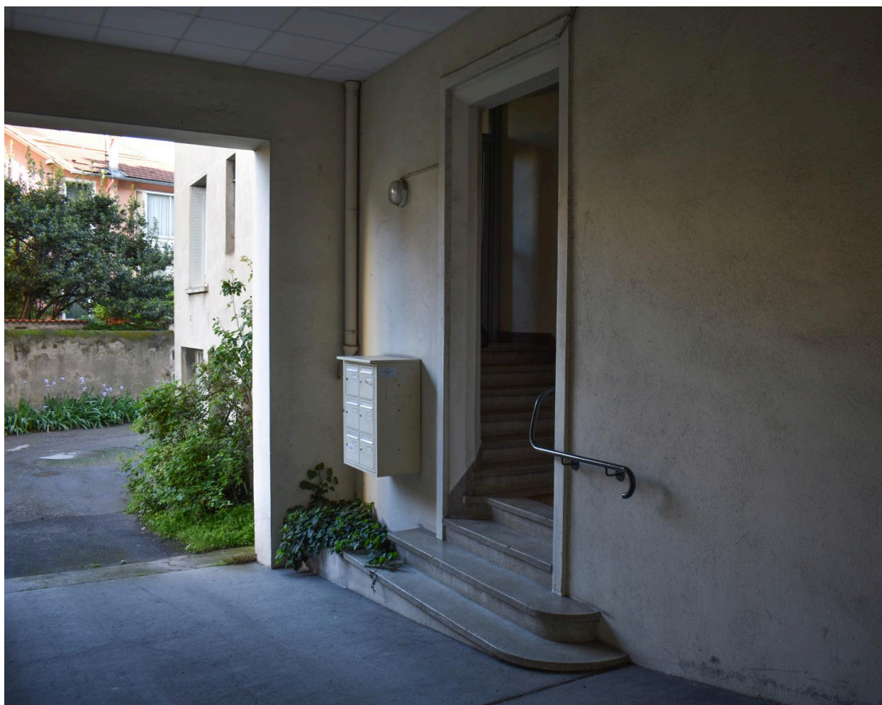
Passage carrossable et porte d'entrée latérale
