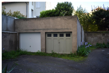
Garages dans la cour arrière de l'immeuble Phot. Félicie Fougère IVR84_20246301249NUCA
