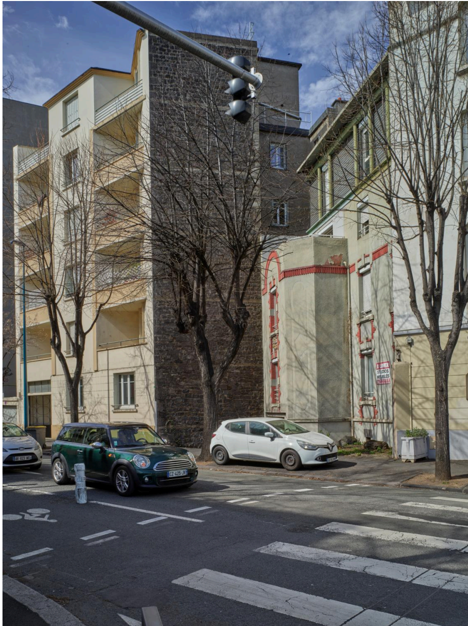
Façades sur le boulevard Cote-Blatin
