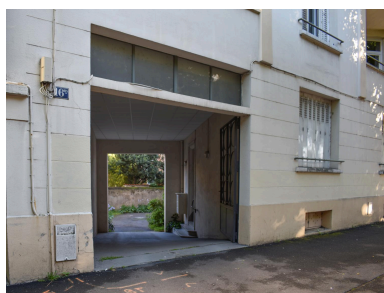
Rez-de-chaussée à passage carrossable Phot. Félicie Fougère IVR84_20246301247NUCA
