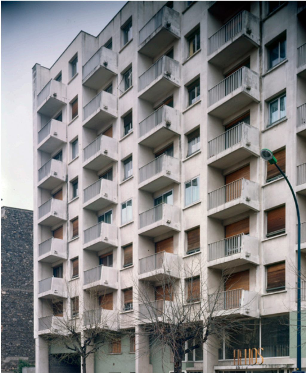
Détail de façade sur le boulevard Cote-Blatin
