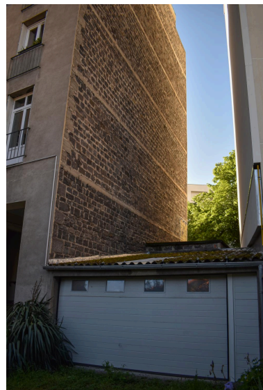
Élévation aveugle latérale de l'immeuble Phot. Félicie Fougère IVR84_20246301250NUCA
