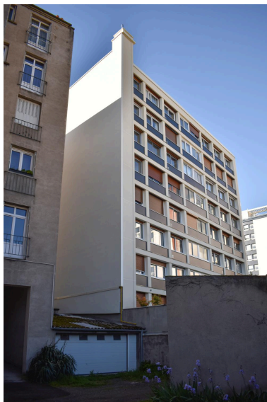
Élévation aveugle latérale et façade arrière de l'immeuble mitoyen (n° 18 bd Cote-Blatin) Phot. Félicie Fougère IVR84_20246301246NUCA
