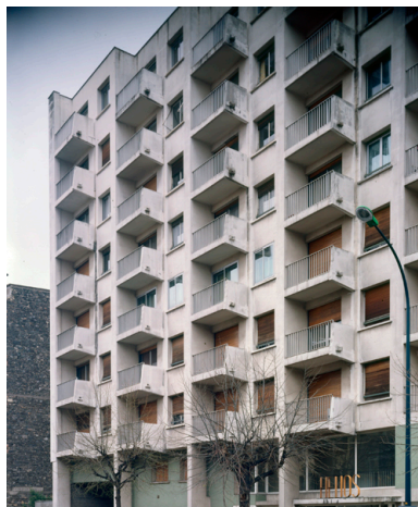
Détail de façade sur le boulevard Cote-Blatin Phot. Roger Choplain, Phot. Roland Maston IVR83_20246390003VA
