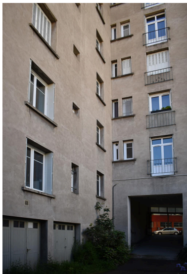
Elévation postérieure sur la cour Phot. Félicie Fougère IVR84_20246301251NUCA
