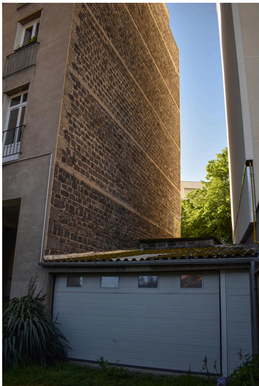
Elévation aveugle latérale de l'immeuble
