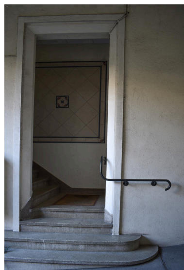
Entrée de l'immeuble dans le passage carrossable Phot. Félicie Fougère IVR84_20246301248NUCA
