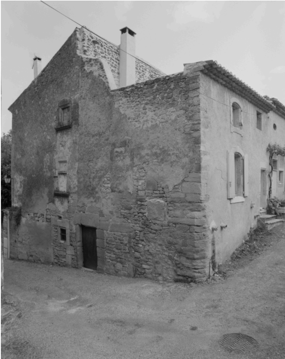
Elévation latérale d'une maison du vieux village (B1 889).
