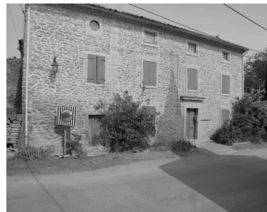
Margerie, rue de Montségur, élévation est de la maison autrefois presbytère (C3 759) Phot. Alain Franchella IVR82_19972600229X
