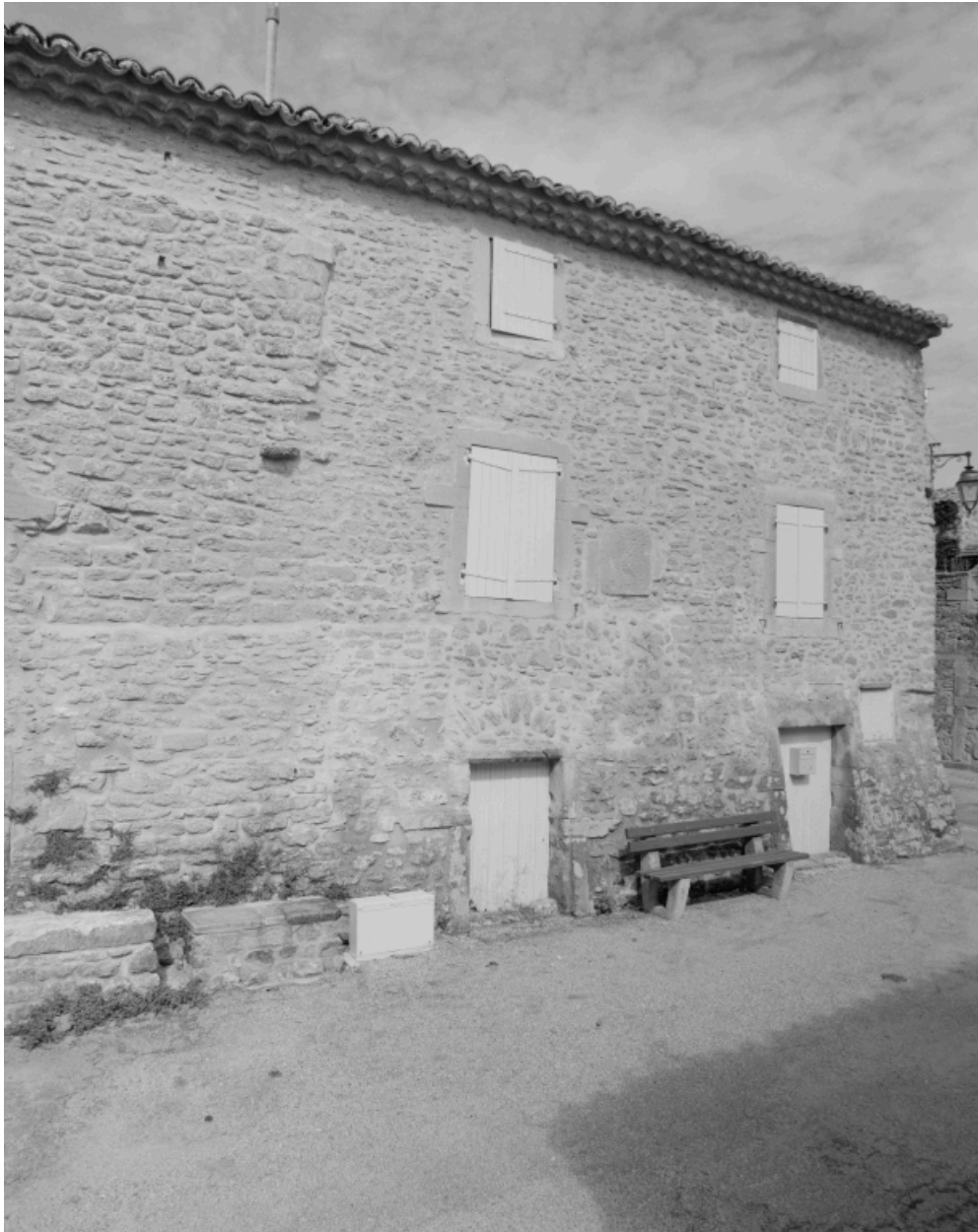
Margerie, la Placette, vue est du logis (C3 722)
