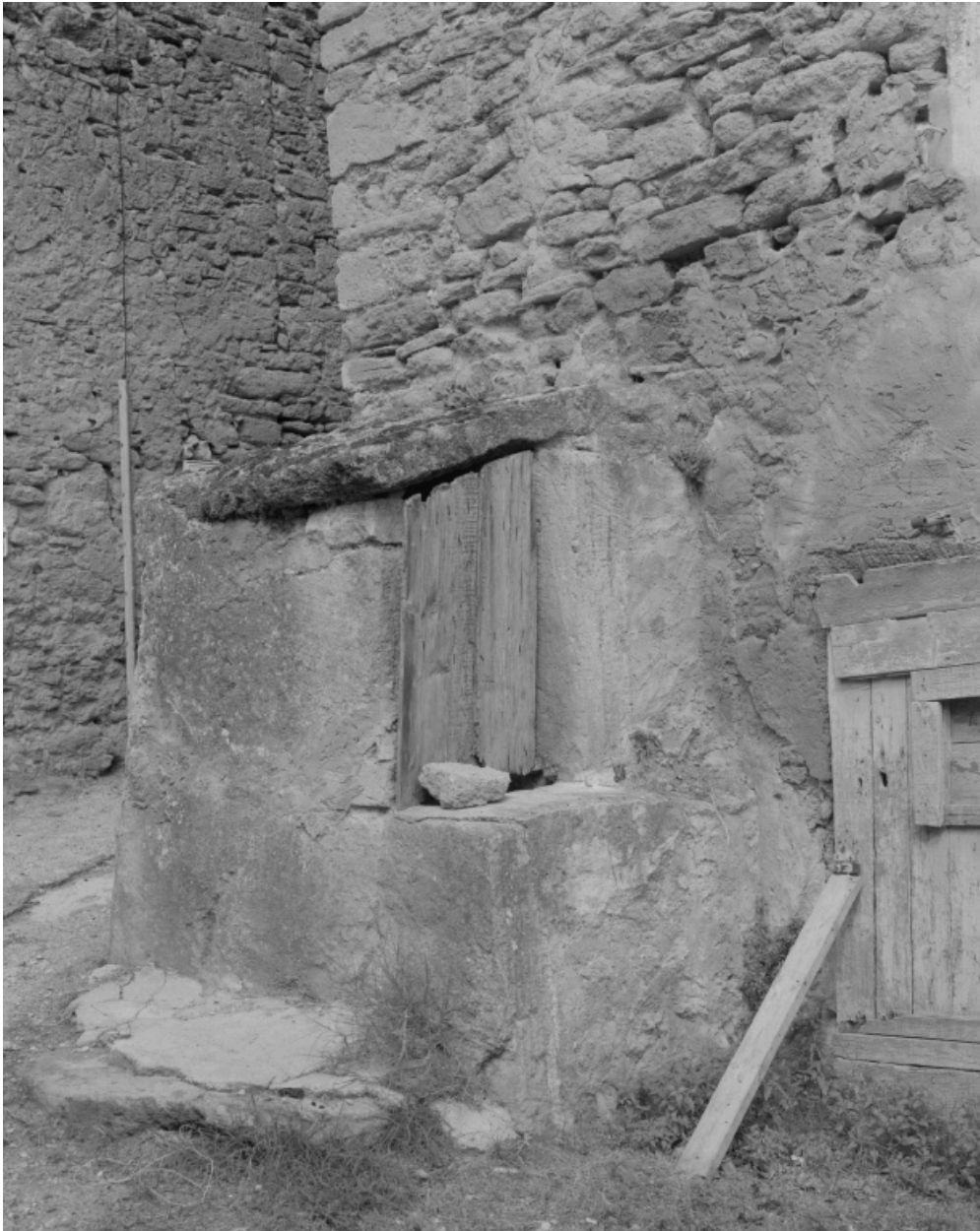
Margerie, rue de l'Eglise, vue du puits accolé à une maison (C3 725)
