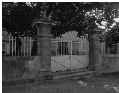
Entrée d'une maison du village (B1 231). Phot. Alain Franchella IVR82_19972600265X
