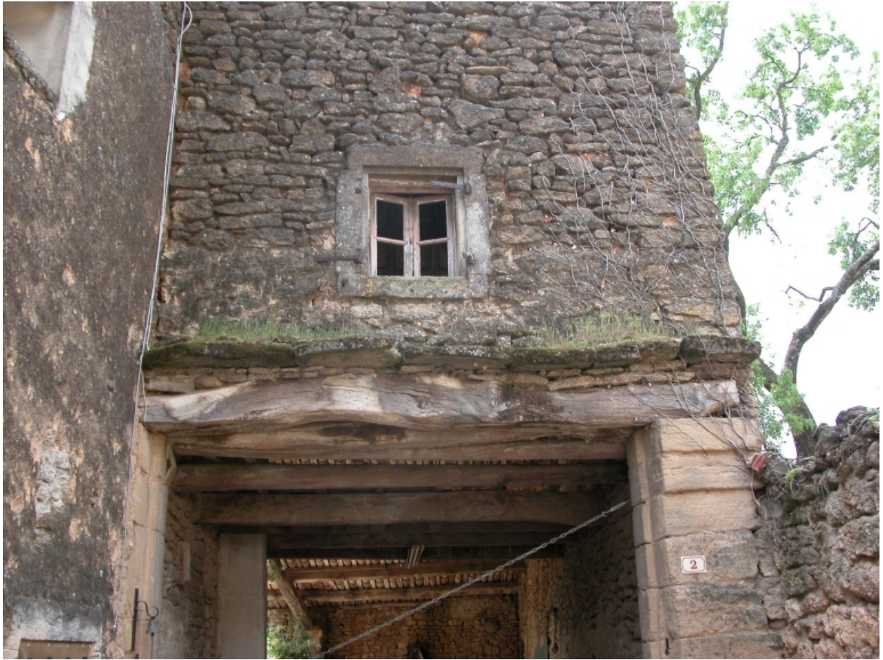
Margerie, 2 impasse des Aires ; vue sud du passage d'entrée de la maison
