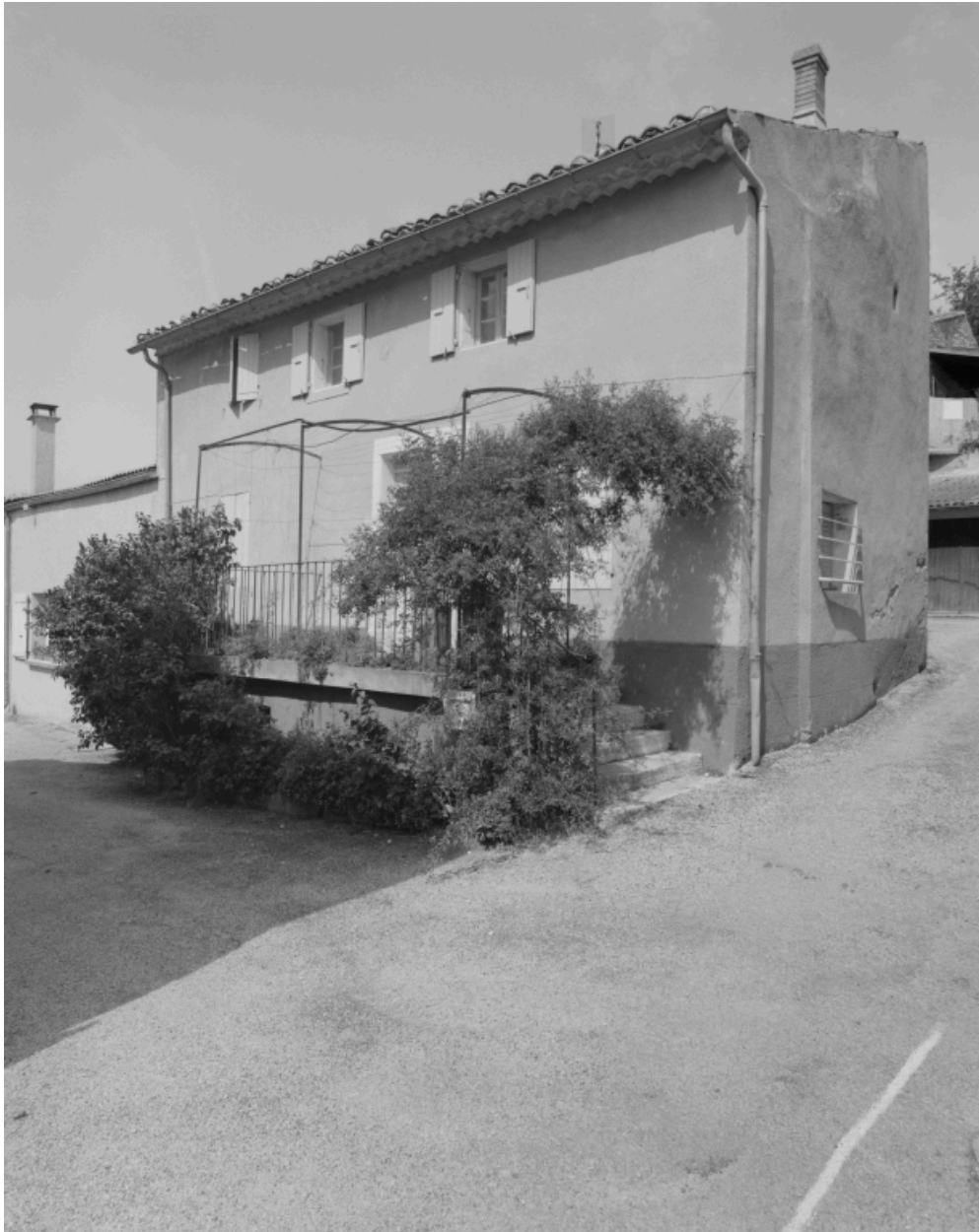
Elévation principale de la maison (B1 288).
