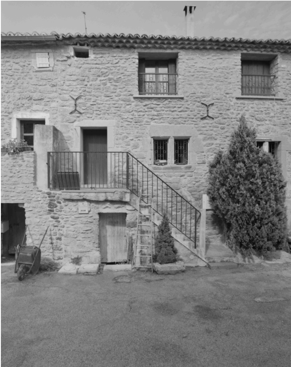
Margerie, la Placette, vue est du logis (C3 724)
