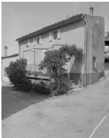
Elévation principale de la maison (B1 288). Phot. Alain Franchella IVR82_19972600262X
