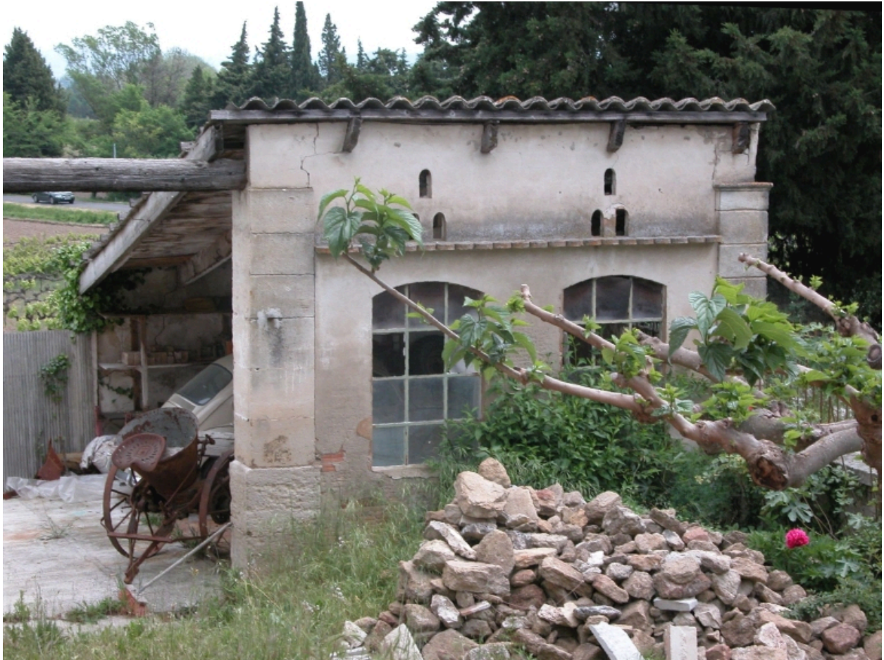
Les Launes ; vue ouest du pigeonnier
