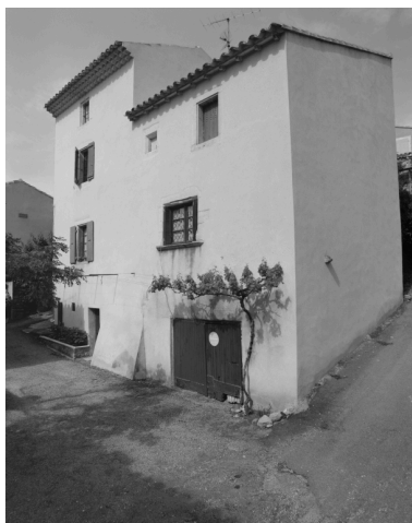
Elévation principale de la maison (B1 823). Phot. Alain Franchella IVR82_19972600264X
