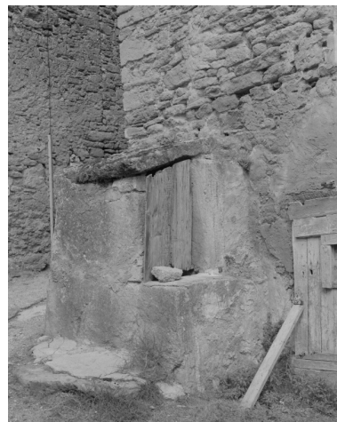
Margerie, rue de l'Eglise, vue du puits accolé à une maison (C3 725) Phot. Alain Franchella IVR82_19972600356X
