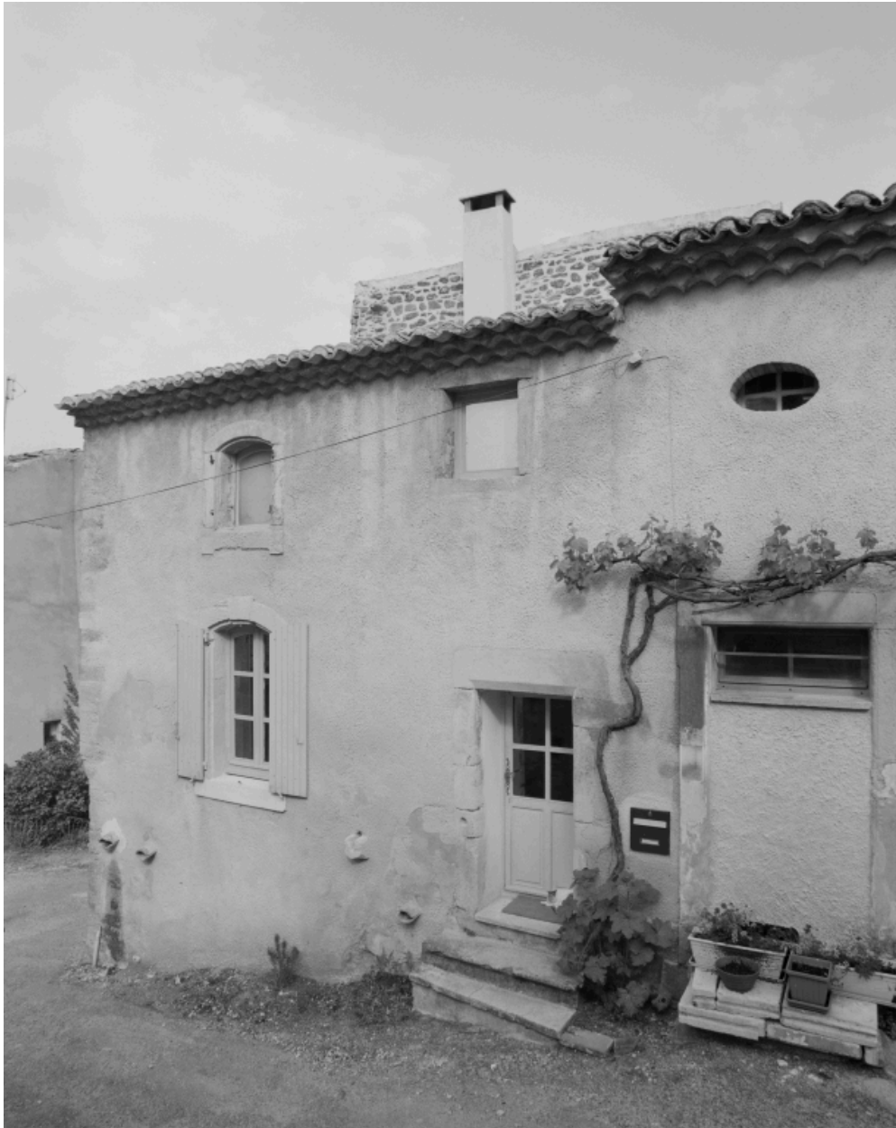
Elévation principale d'une maison du vieux village (B1 889).
