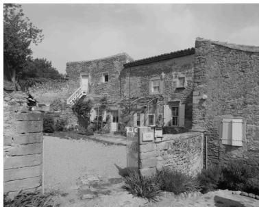
Vue générale de la maison construite contre l'enceinte. Phot. Alain Franchella IVR82_19972600256X
