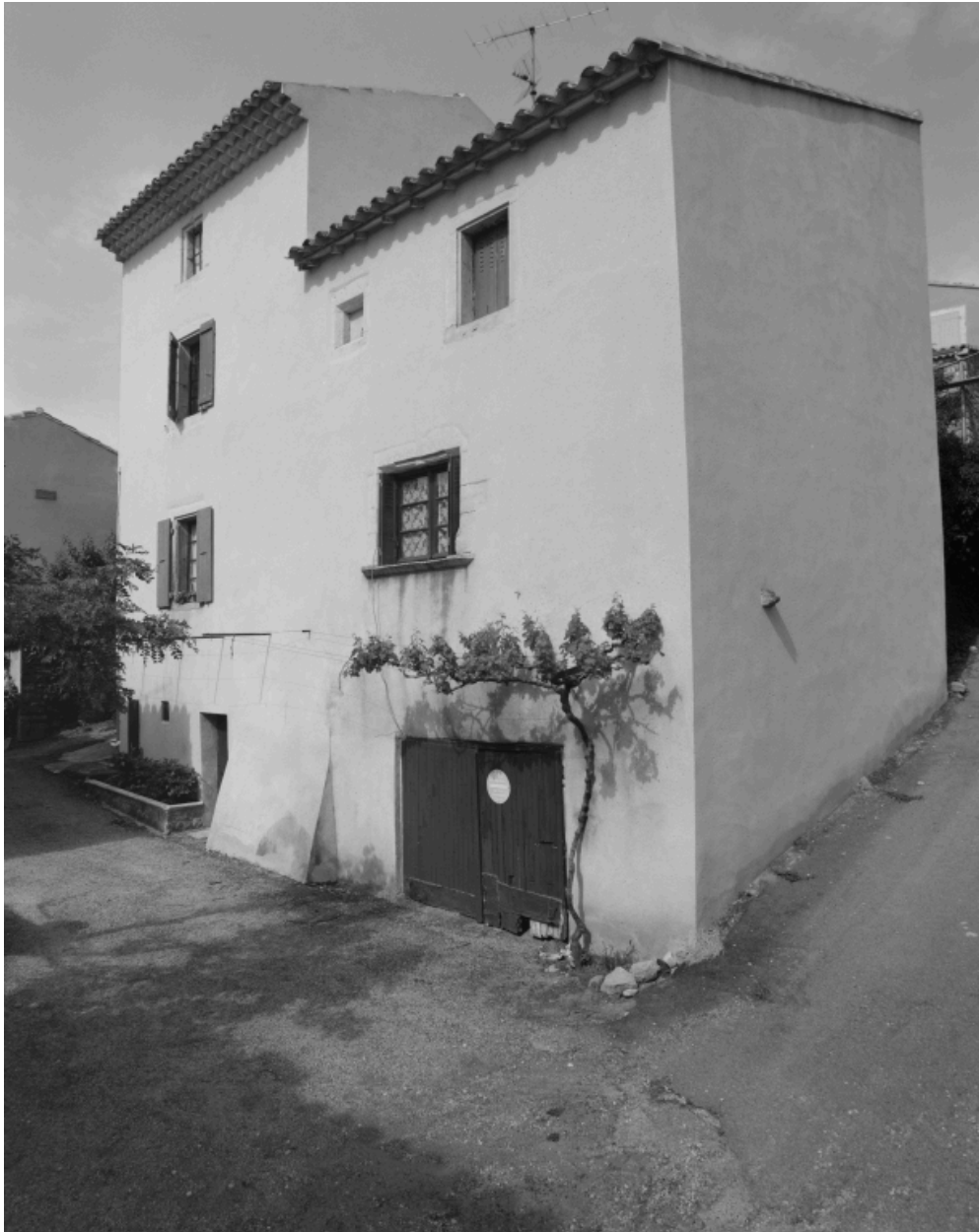
Elévation principale de la maison (B1 823).
