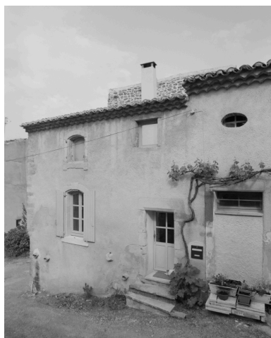
Elévation principale d'une maison du vieux village (B1 889). Phot. Alain Franchella IVR82_19972600255X
