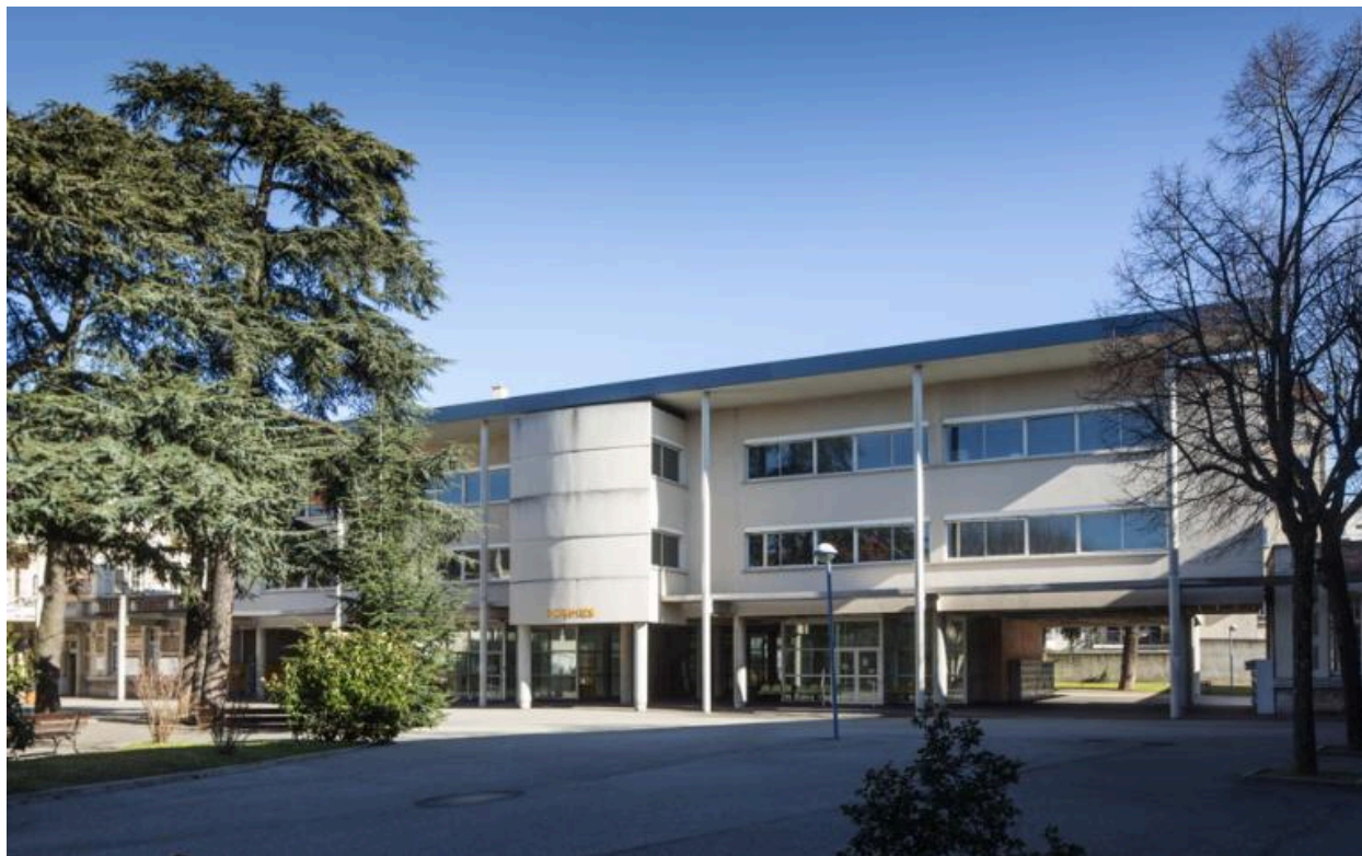
Bâtiment des sciences : façade ouest sur cour
