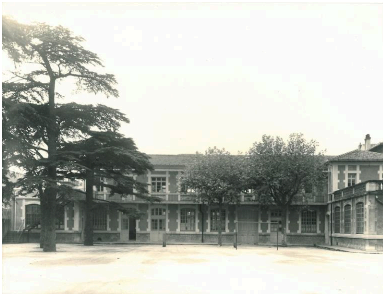
Les bâtiments après travaux, 1958
