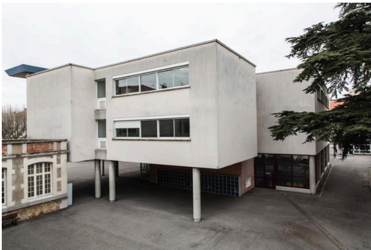
Bâtiment des sciences : façade est et articulation avec le pavillons du bâtiment sud
