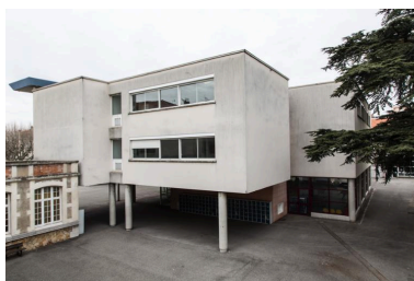
Bâtiment des sciences : façade est et articulation avec le pavillons du bâtiment sud Phot. Pascal Lemaître IVR82_20152600098NUCA
