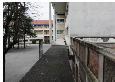
Bâtiment des sciences : partie supérieure de la galerie Phot. Pascal Lemaître IVR82_20152600099NUCA
