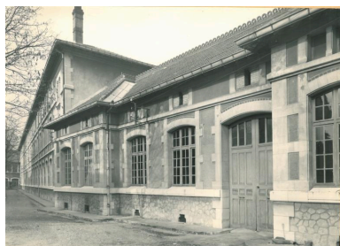
Façade sud de l'aile sud-ouest, 1955 Autr. auteur inconnu IVR82_20152600062NUCB
