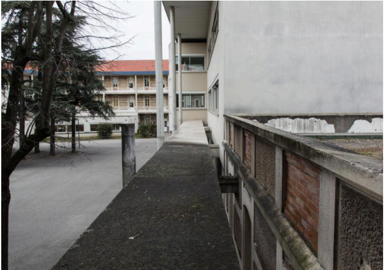
Bâtiment des sciences : partie supérieure de la galerie
