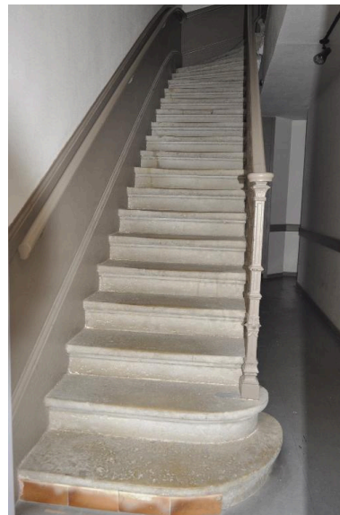
Vue intérieure : première volée de l'escalier en revers de façade Phot. Magali Delavenne IVR84_20166902251NUCA
