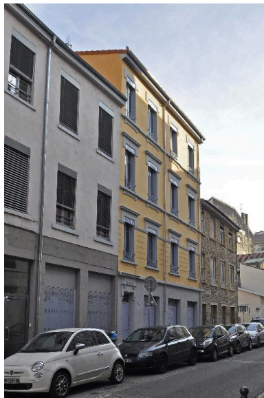
Vue d'ensemble depuis l'ouest Phot. Magali Delavenne IVR84_20166902249NUCA
