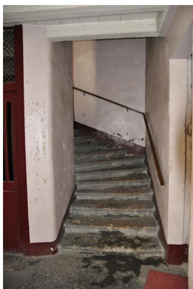
Vue du départ de l'escalier Phot. Nadine Halitim-Dubois IVR82_20146900289NUCA
