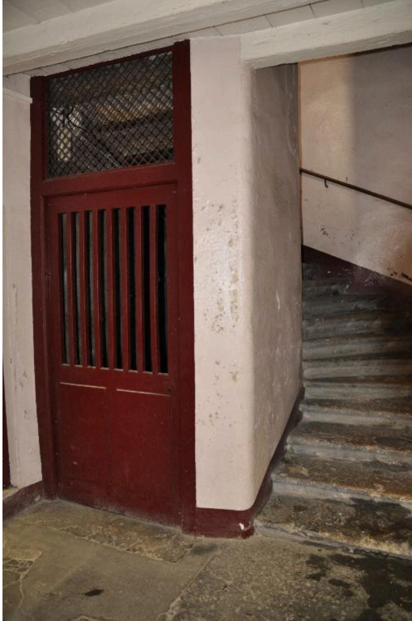
Vue de l'escalier et de la porte d'accès à la cave
