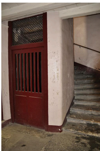
Vue de l'escalier et de la porte d'accès à la cave Phot. Nadine Halitim-Dubois IVR82_20146900290NUCA
