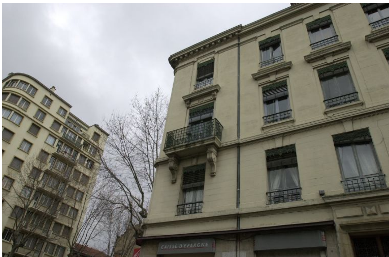
Détail des fenêtres, rue Marc-Antoine-Petit
