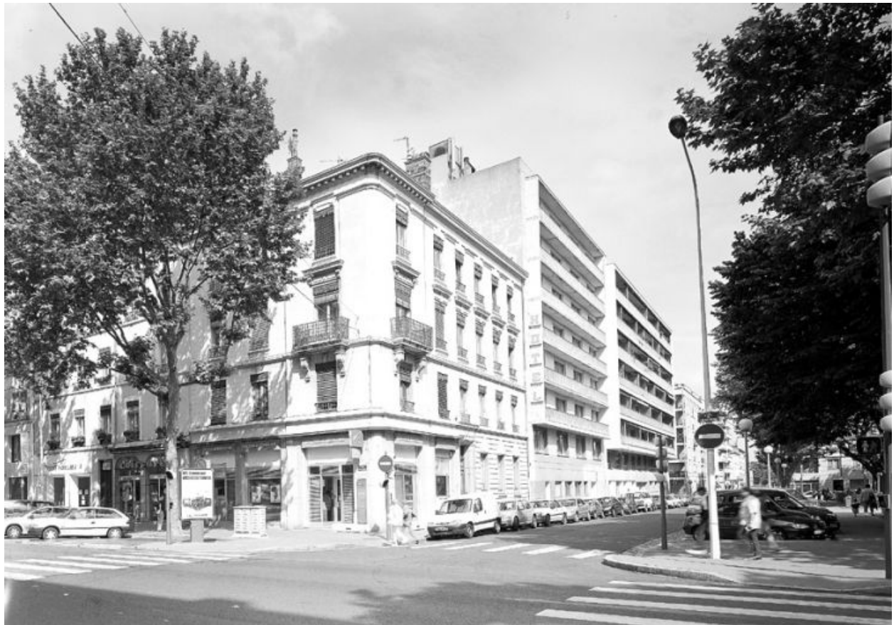
Vue générale depuis le sud-ouest
