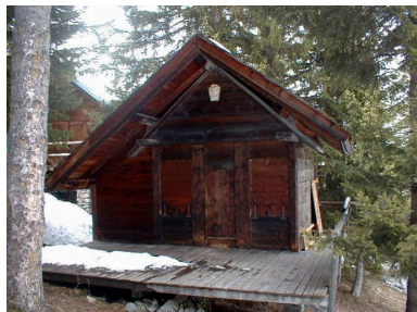
Vue générale Phot. Jean-François Lyon-Caen IVR82_20017300007NUCA
