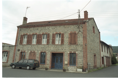
Vue d'ensemble, de trois-quarts, de la façade de la maison depuis la route. Phot. Thierry Monnet IVR82_20034200742ZE
