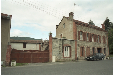
Vue d'ensemble de la maison depuis la route. Phot. Thierry Monnet IVR82_20034200743ZE
