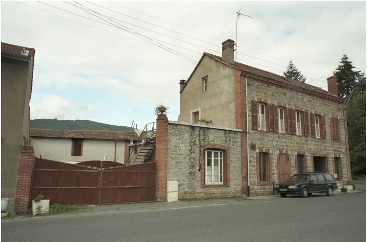
Vue d'ensemble de la maison depuis la route.
