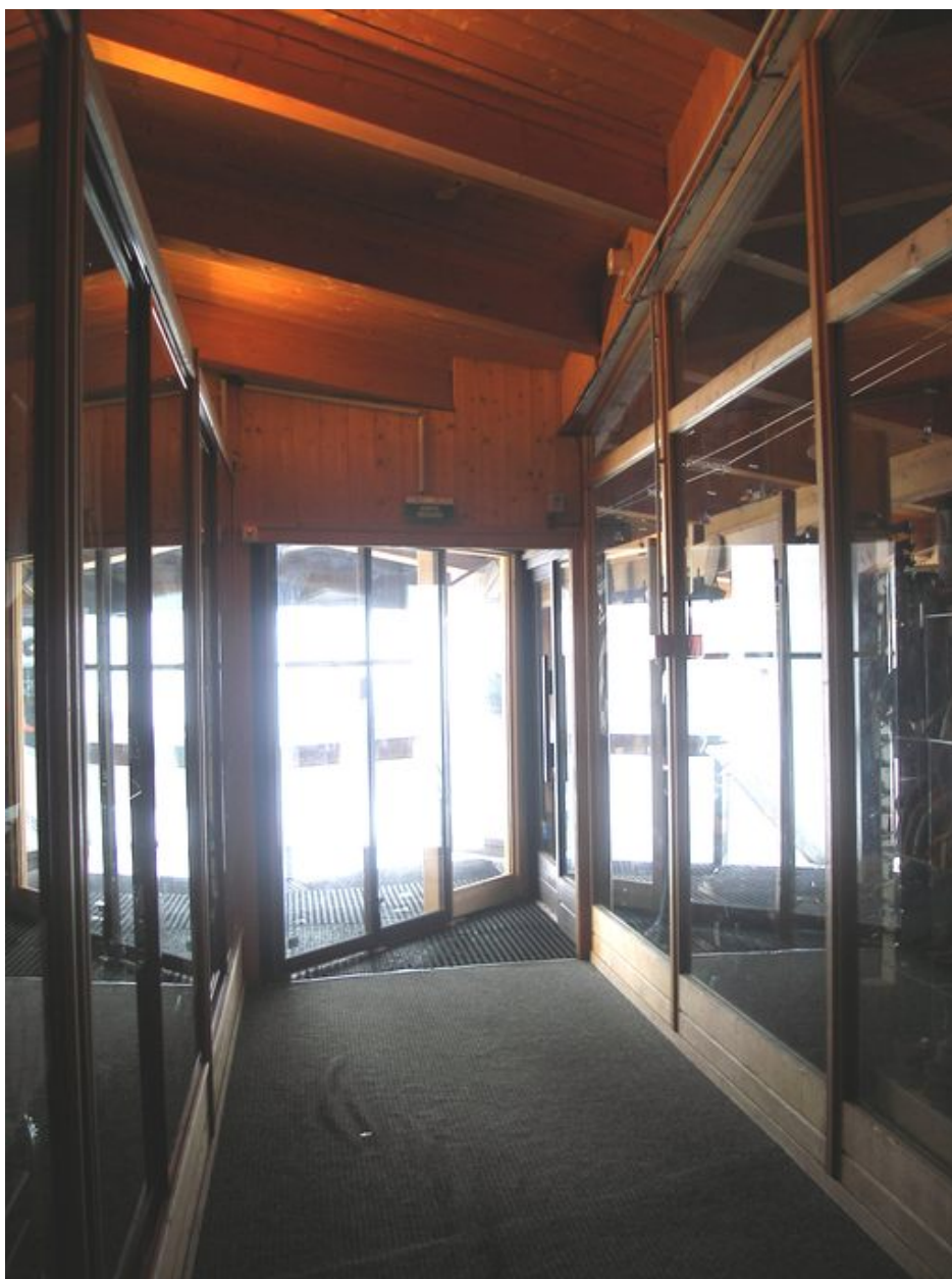
La galerie desservant les commerces de l'entresol et reliant le rez-de-chaussée avec le 2e niveau place des Dromonts
