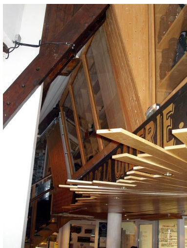
Baies des commerces de l'entresol donnant sur la galerie principale Phot. Jean-François Lyon- Caen, Phot. C. Salomon-Pelen IVR82_20087401121NUCA
