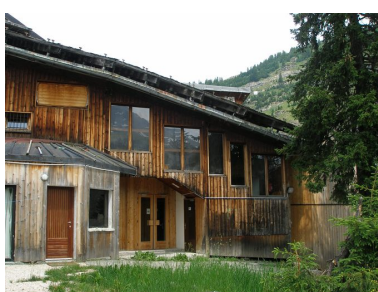
Entrée sud sur la terrasse à l'entresol, accès à l'hôtel et à la galerie marchande Phot. Jean-François Lyon-Caen, Phot. C. Salomon-Pelen IVR82_20087401102NUCA
