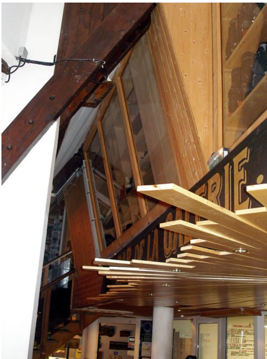
Baies des commerces de l'entresol donnant sur la galerie principale
