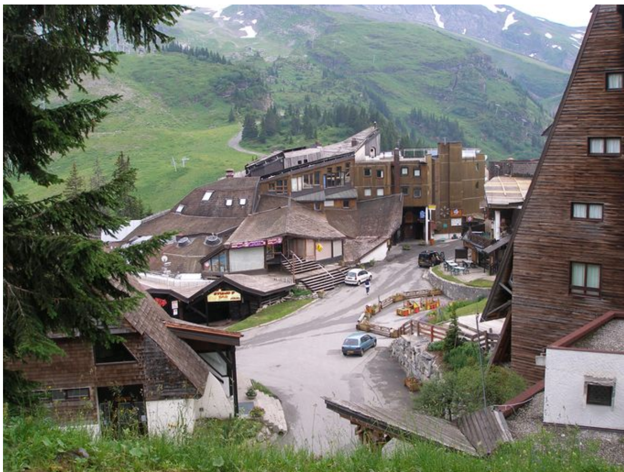
Vue générale depuis l'amont : les toitures polygonales des commerces et la façade nord de l'hôtel
