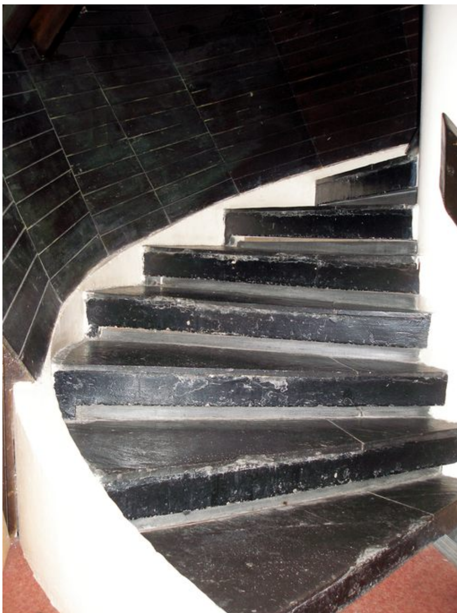
L'escalier secondaire entre le rez-de-chaussée et le 2e niveau (refend C)
