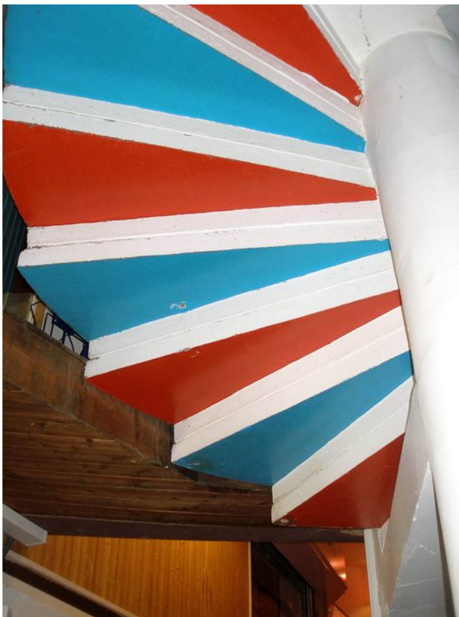
L'ancien escalier entre le rez-de-chaussée et le 2e niveau (travée 42)
