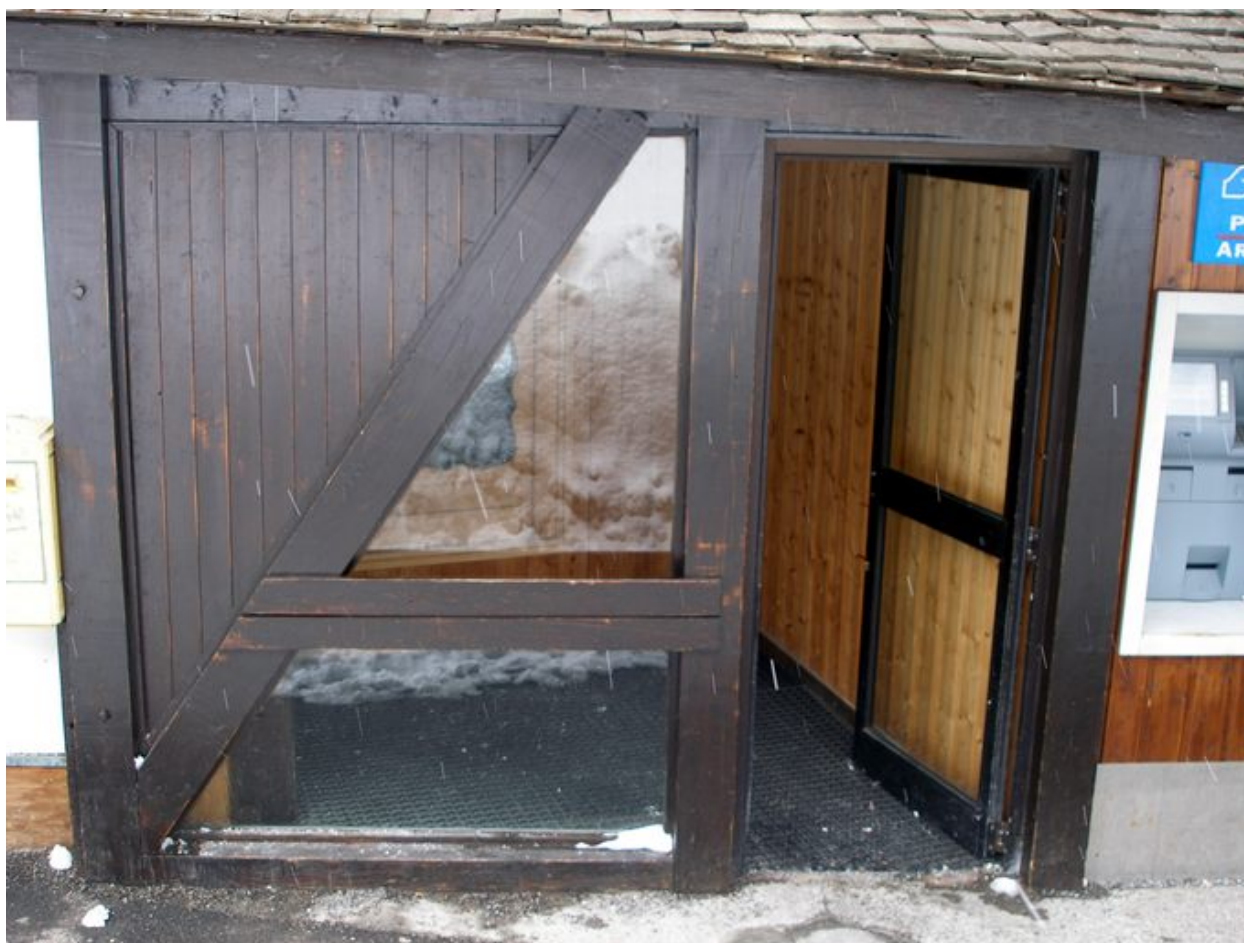
Détail de la porte d'entrée, vitrage en 'A'
