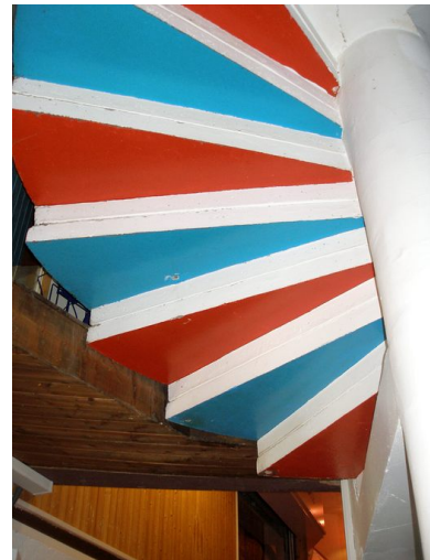
L'ancien escalier entre le rez-de-chaussée et le 2e niveau (travée 42) Phot. Jean-François Lyon-Caen, Phot. C. Salomon-Pelen IVR82_20087401114NUCA
