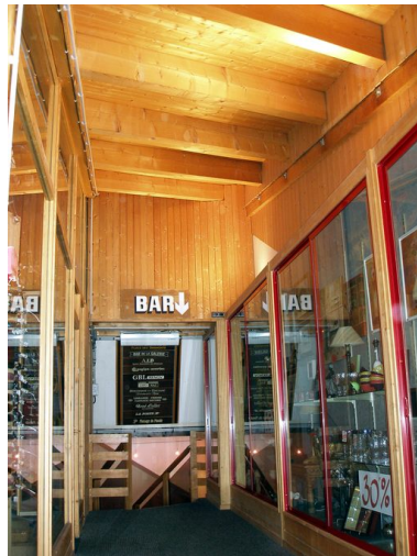
L'accès au bar depuis la galerie desservant les commerces de l'entresol Phot. Jean-François Lyon-Caen, Phot. C. Salomon-Pelen IVR82_20087401116NUCA
