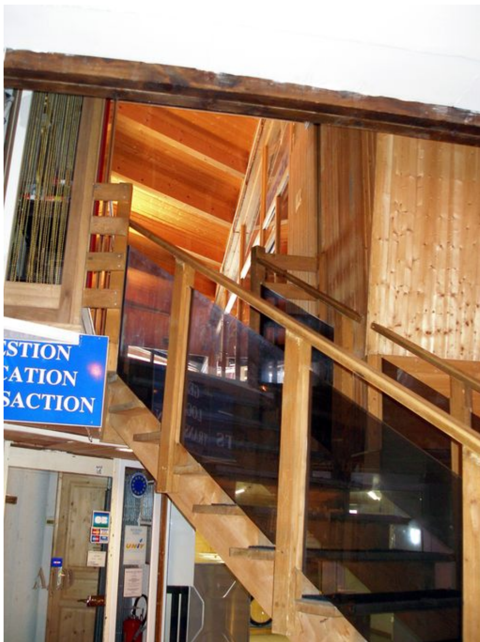
L'escalier principal entre le rez-de-chaussée et le 2e niveau (travée 31)
