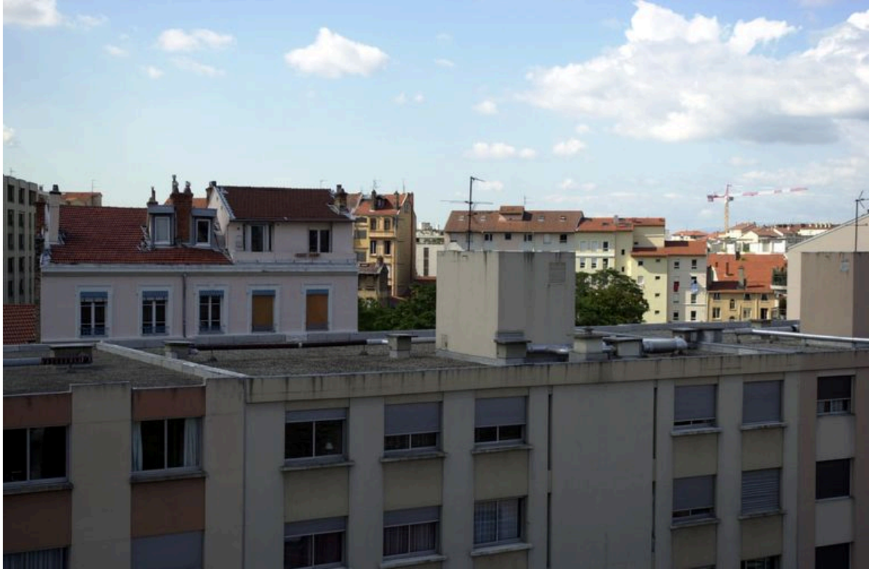
Vue du toit terrasse
