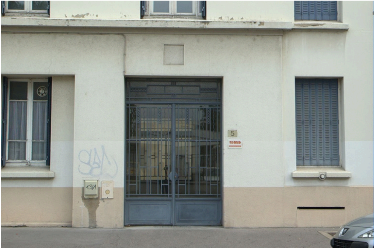
Entrée principale du 5 (entrée de l'immeuble)
