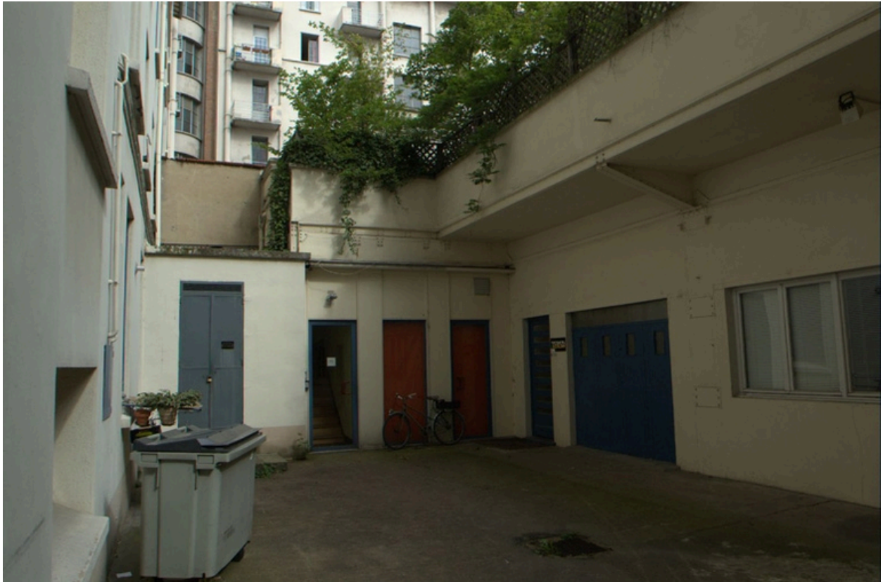
Vue d'ensemble et entrée principale dans la cour de l'immeuble du n° 5
