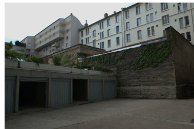
Détail façade nord Phot. Nadine Halitim-Dubois IVR82_20086900390NUCA
