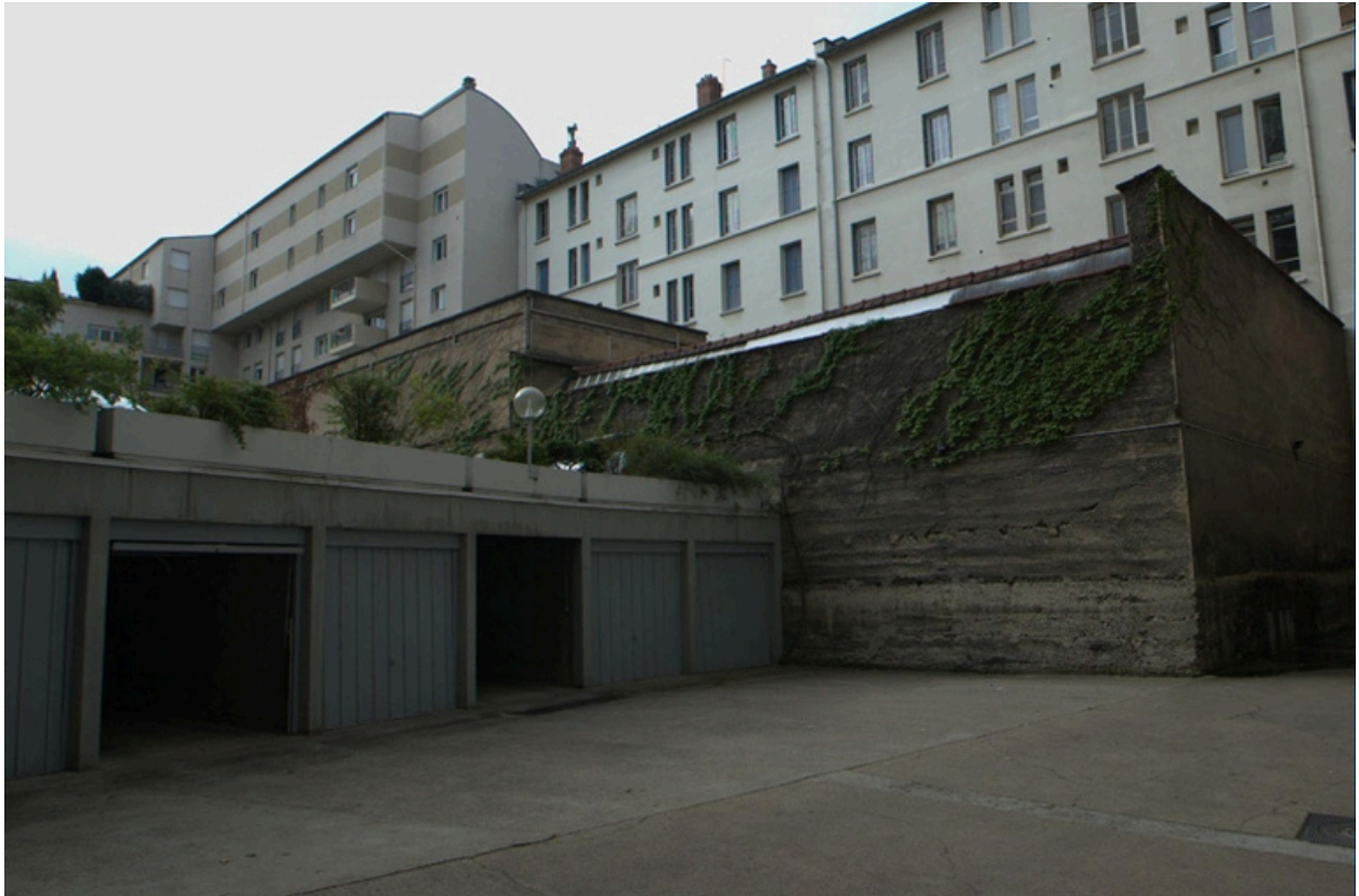
Détail façade nord
