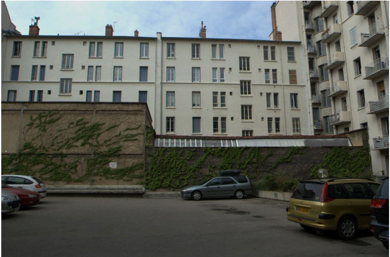
Vue générale nord des bâtiments en coeur d'îlot
