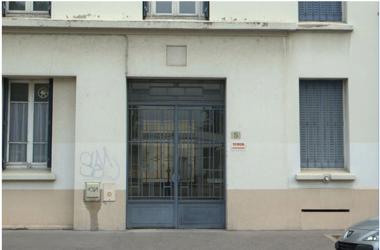
Entrée principale du 5 (entrée de l'immeuble)
