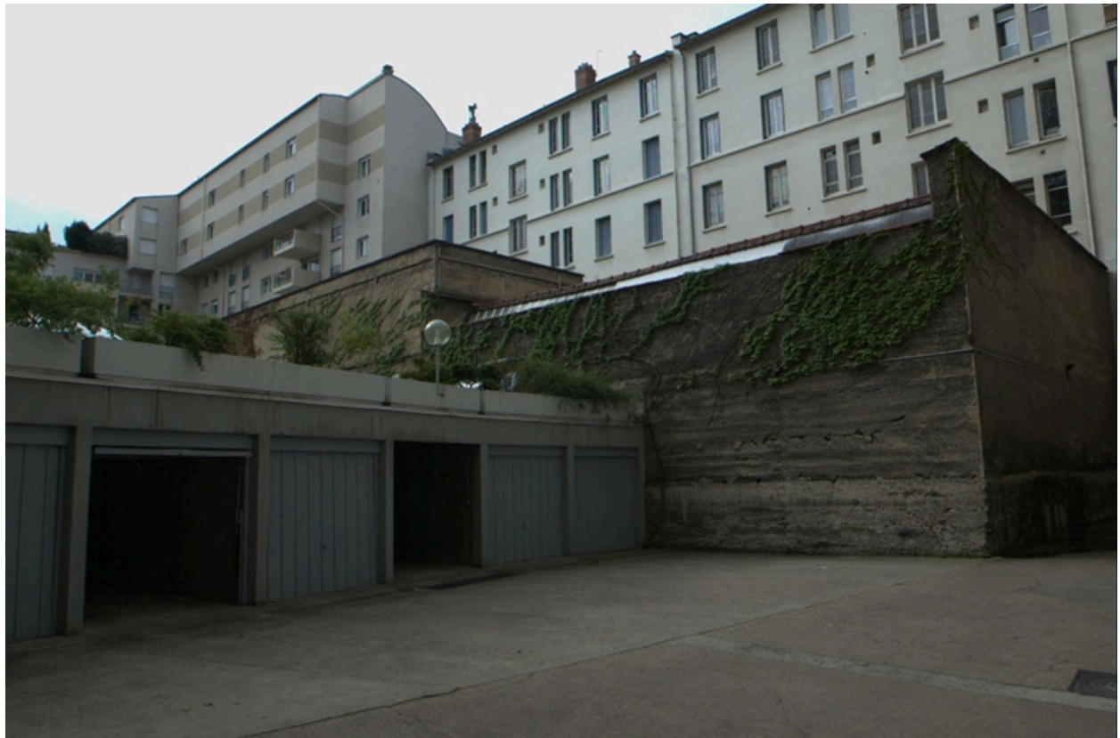
Détail façade nord
