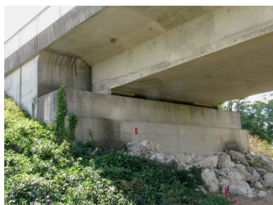
Culée de la rive gauche, face amont Phot. I. Havard IVR82_20100700161NUCA
