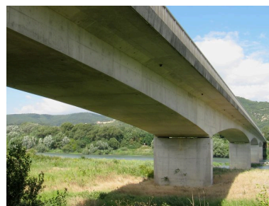
Vue générale, face amont (depuis la rive gauche) Phot. I. Havard IVR82_20100700160NUCA
