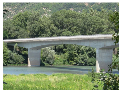
Vue partielle, face aval (depuis la rive gauche) Phot. I. Havard IVR82_20100700163NUCA
