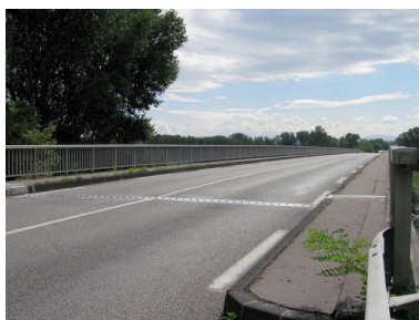
Chaussée (depuis la rive gauche) Phot. I. Havard IVR82_20100700165NUCA
