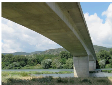
Dessous du tablier, face amont (depuis la rive gauche) Phot. I. Havard IVR82_20100700162NUCA
