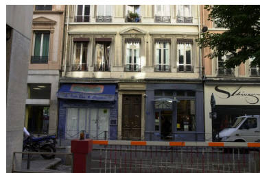
Façade, rez-de-chaussée et premier étage Phot. Bernard Ducouret IVR82_20046900970NUCA
