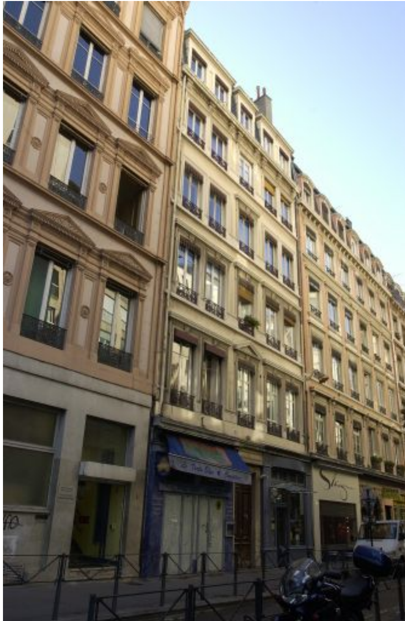
Façade, vue générale de trois quarts
