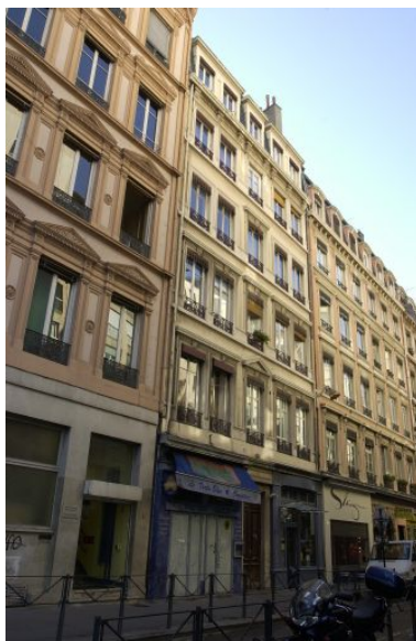
Façade, vue générale de trois quarts Phot. Bernard Ducouret IVR82_20046900969NUCA
