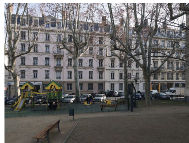
Elévation sur la rue Cavenne, vue générale Phot. Didier Gourbin IVR82_20126902019NUCA
