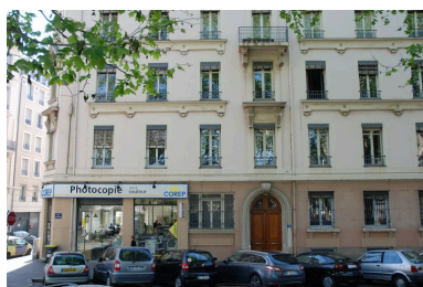
Détail de l'élévation sur la rue Cavenne Phot. Catherine Guillot IVR82_20126900888NUCA
