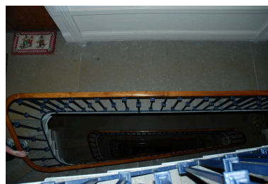
Vue de la cage d'escalier Phot. Catherine Guillot IVR82_20126900998NUCA
