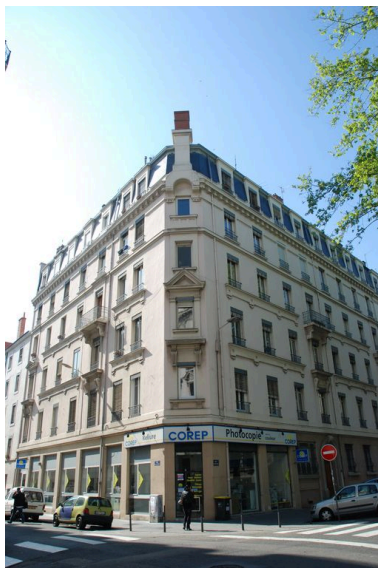
Vue générale Phot. Catherine Guillot IVR82_20126900887NUCA
