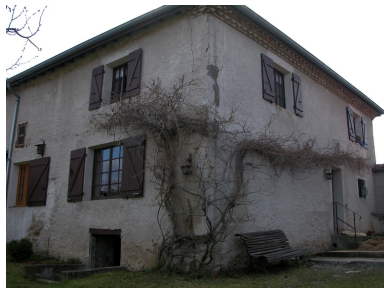
Vue générale. Phot. Thierry Monnet IVR82_20124201959NUCA
