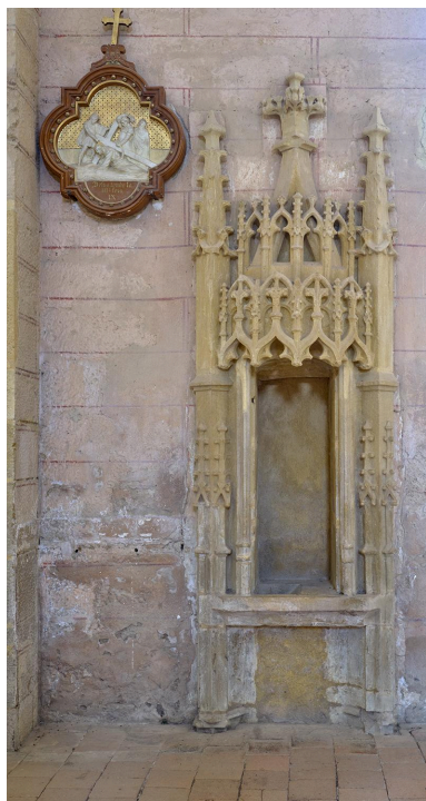
Lavabo en niche (classé MH), dit piscine baptismale dans l'arrêté de classement Phot. Franck Trabouillet IVR84_20234200288NUCA
