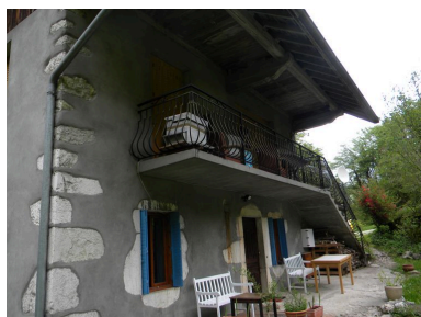
Vue générale de la façade principale du martinet. Phot. Jérôme Daviet IVR82_20117400502NUCA
