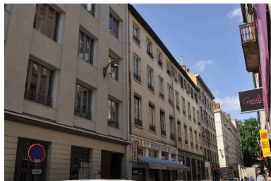
Vue d'ensemble, élévation sur rue Phot. Catherine Guégan IVR82_20156901087NUCA
