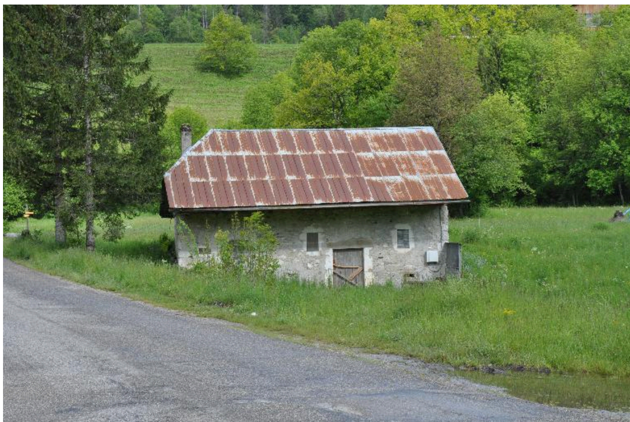
Vue générale du site.
