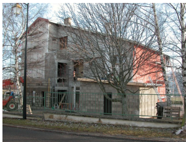
Vue d'ensemble de trois-quarts arrière droit de la nouvelle école en cours de rénovation. Phot. Thierry Monnet IVR82_20124200184NUCA
