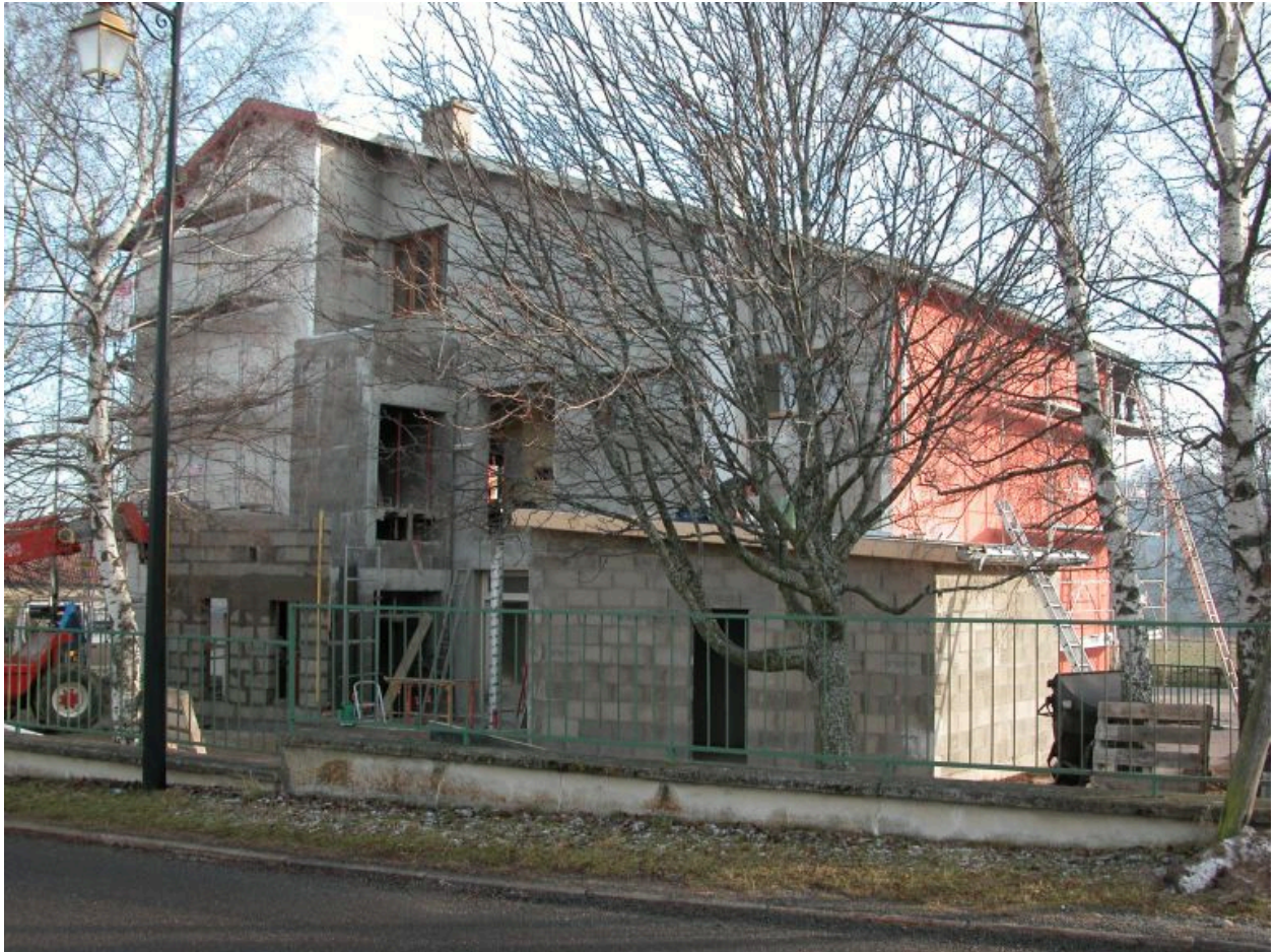
Vue d'ensemble de trois-quarts arrière droit de la nouvelle école en cours de rénovation.
