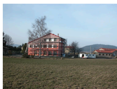
Vue d'ensemble de la nouvelle école de Lérigneux en cours de rénovation. Phot. Thierry Monnet IVR82_20124200182NUCA
