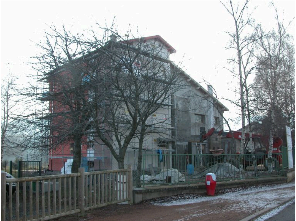
Vue d'ensemble de trois-quarts avant de la nouvelle école en cours de rénovation.
