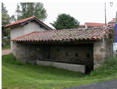
Vue d'ensemble du lavoir du bourg (1997 AL 44). Phot. Thierry Monnet IVR82_20124200550NUCA
