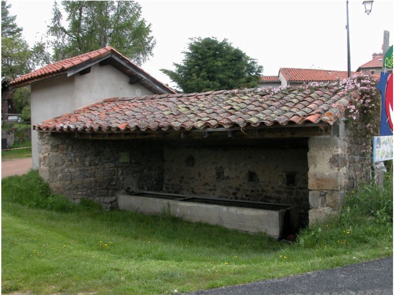
Vue d'ensemble du lavoir du bourg (1997 AL 44).
