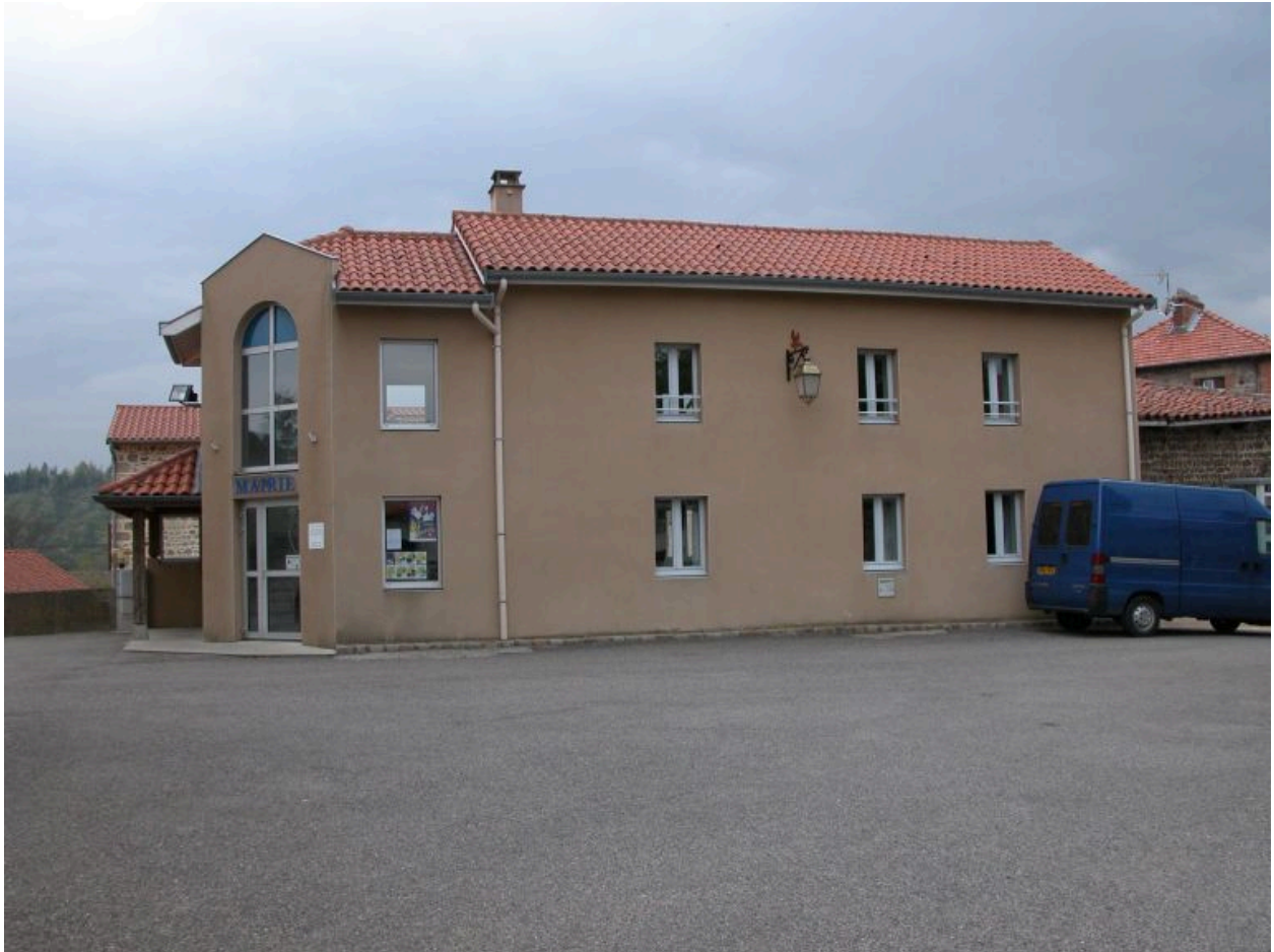
Vue d'ensemble de la mairie actuelle, place de l'église.
