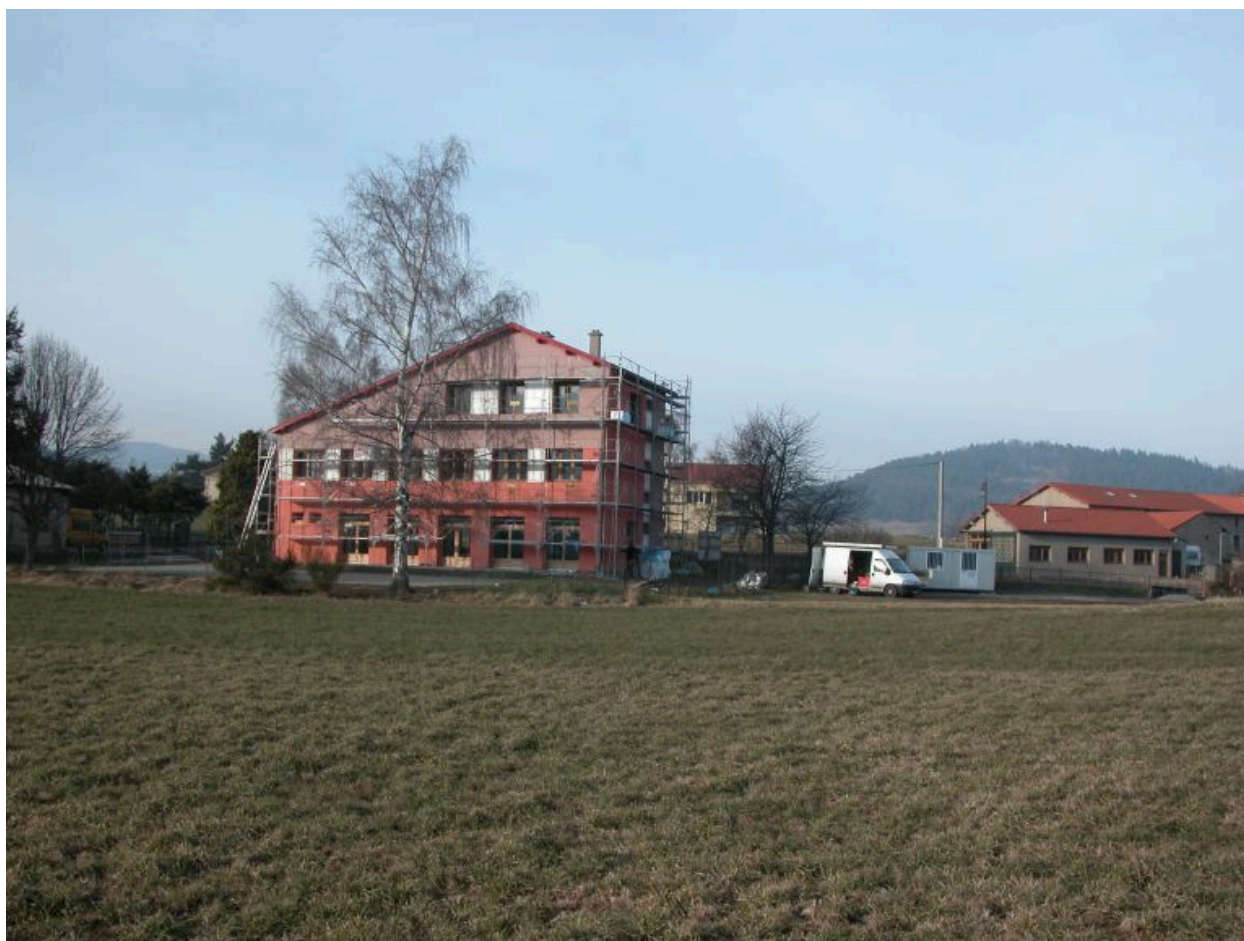
Vue d'ensemble de la nouvelle école de Lérigneux en cours de rénovation.
