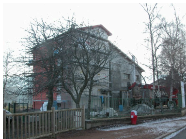
Vue d'ensemble de trois-quarts avant de la nouvelle école en cours de rénovation. Phot. Thierry Monnet IVR82_20124200183NUCA
