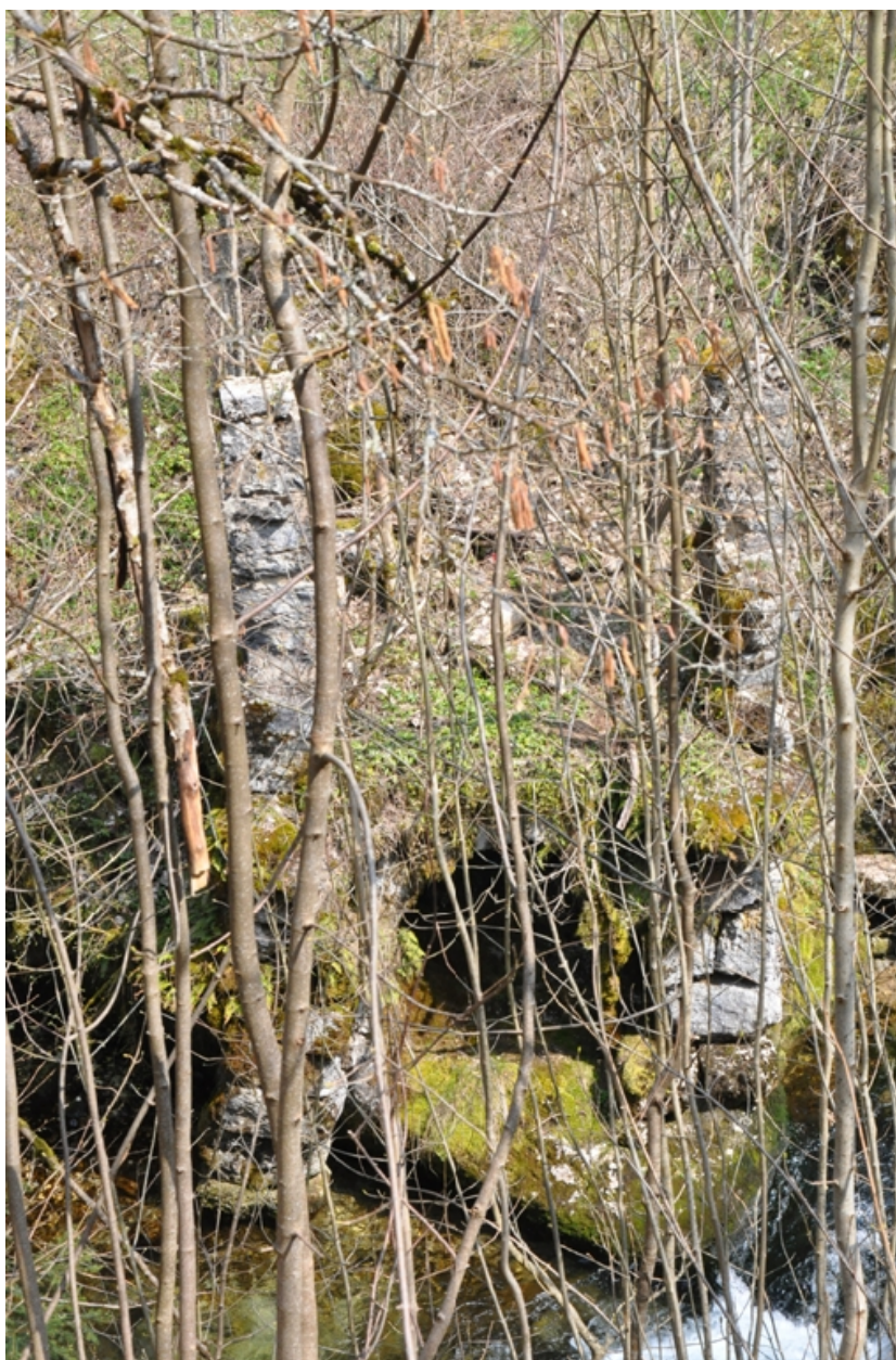
Détail de l'étage de soubassement avec l'arc plein cintre
