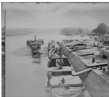
A Frans. Quai du port de Frans, vue depuis le pont (côté Villefranche). Photogr. par [Berthier], vers 1900, plaque de verre 9x9. Repro. Jean-Marie Refflé IVR82_19900100079XB
