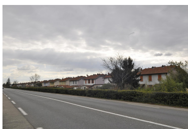
Alignement de maisons ouvrières au bord d'une route nationale 7 (vue sud) Phot. Nadine Halitim-Dubois IVR82_20153800141NUCA
