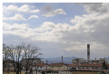
Proximité de l'usine et des cités dans un même paysage Phot. Nadine Halitim-Dubois IVR82_20153800135NUCA
