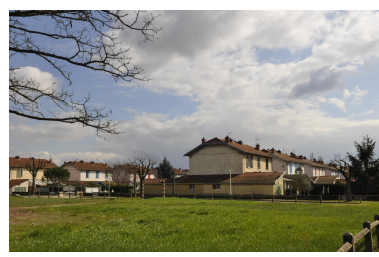
Vue de deux rangées de maisons ouvrières Phot. Nadine Halitim-Dubois IVR82_20153800112NUCA
