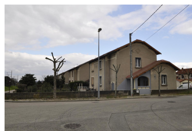
Vue d'un ensemble de maisons des cités ouvrières de Roussillon (cité de la chimie) Phot. Nadine Halitim-Dubois IVR82_20153800103NUCA
