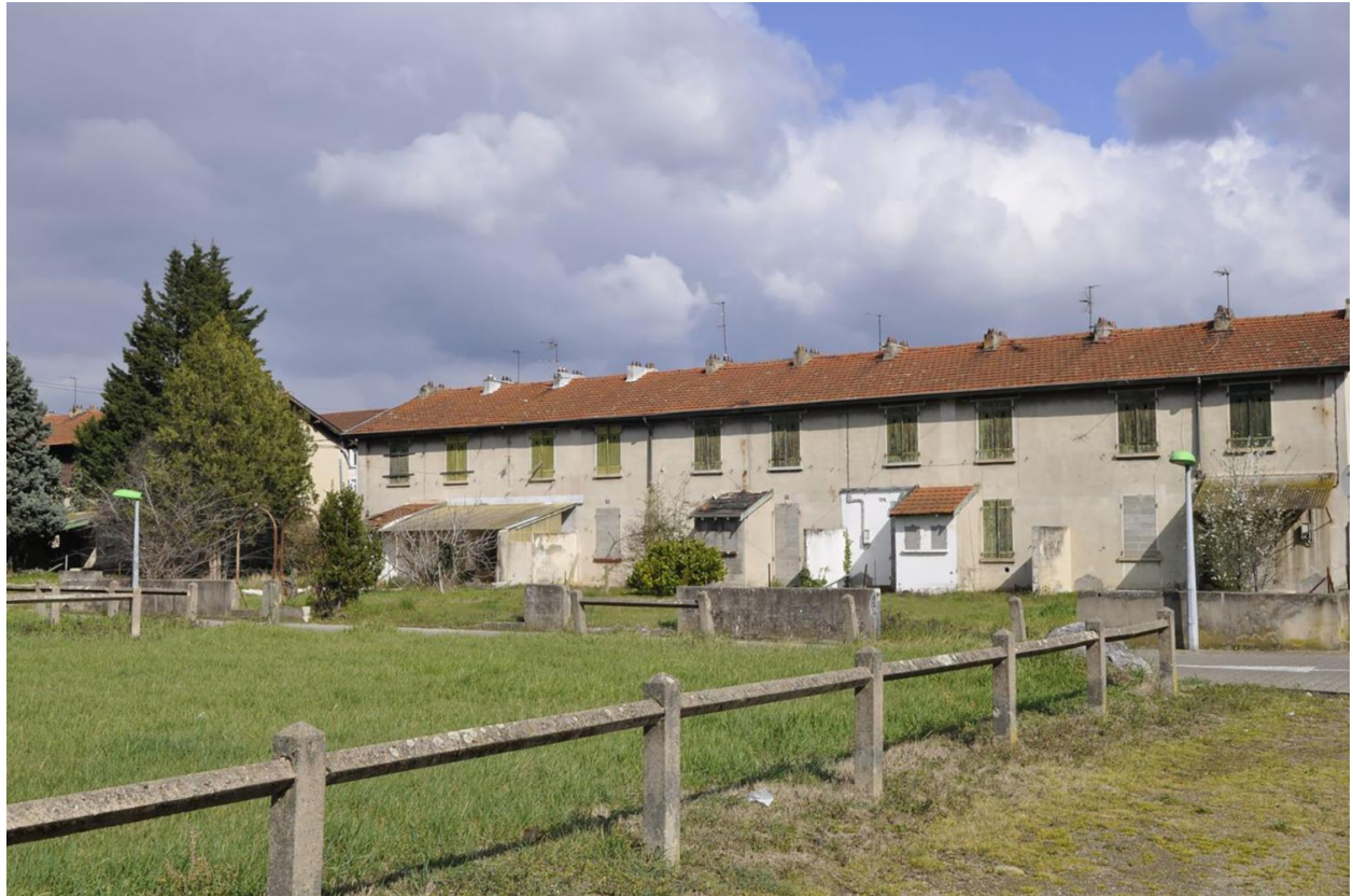
Ancien logement caserne (qui vont être démolis)
