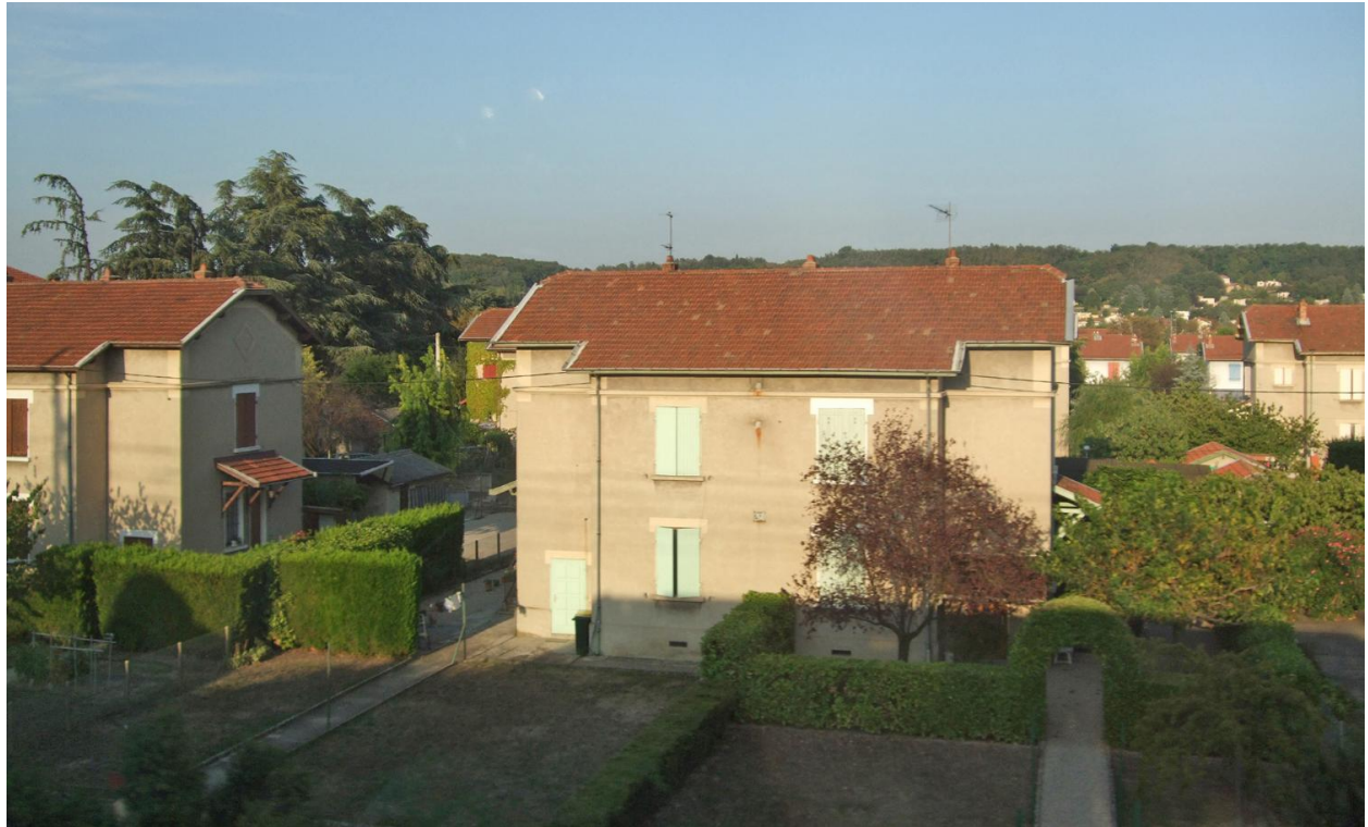
Vue de maisons ouvrières et leurs jardins depuis la voie ferrée
