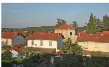
Vue arrière des cités ouvrières avec jardins de Roussillon depuis la voie ferrée Phot. Nadine Halitim-Dubois IVR82_20153800114NUCA
