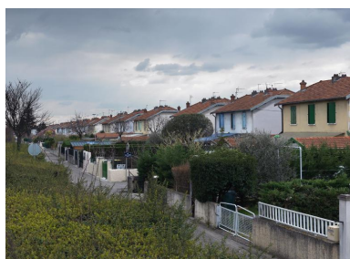
Vue d'ensemble de la cité ouvrière le long de la Nationale 7 Phot. Thierry Leroy IVR84_20163800007NUCAQ
