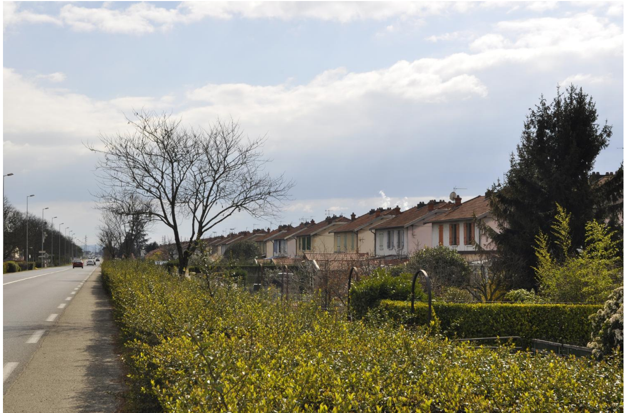
Vue d'ensemble de maisons alignées en bord de la route Nationale 7.
