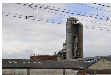
Détail usine et voie ferrée Phot. Nadine Halitim-Dubois IVR82_20153800137NUCA
