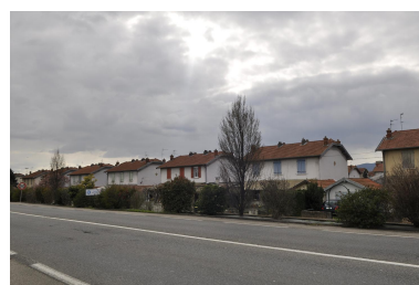
Vue d'un ensemble de maisons ouvrières depuis la route nationale 7. Phot. Nadine Halitim-Dubois IVR82_20153800106NUCA
