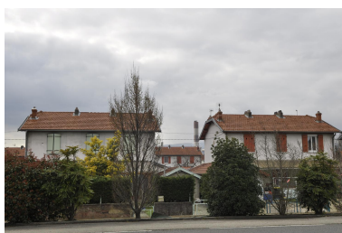
Deux maisons ouvrières des cités ouvrières de Roussillon Phot. Nadine Halitim-Dubois IVR82_20153800102NUCA
