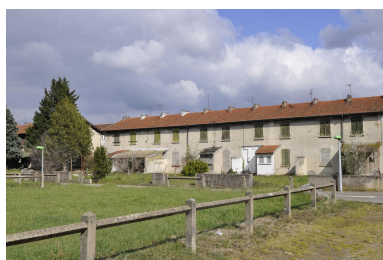
Ancien logement caserne (qui vont être démolis) Phot. Nadine Halitim-Dubois IVR82_20153800113NUCA
