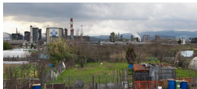
Vue d'ensemble de l'usine Phot. Thierry Leroy IVR84_20163800012NUCAQ
