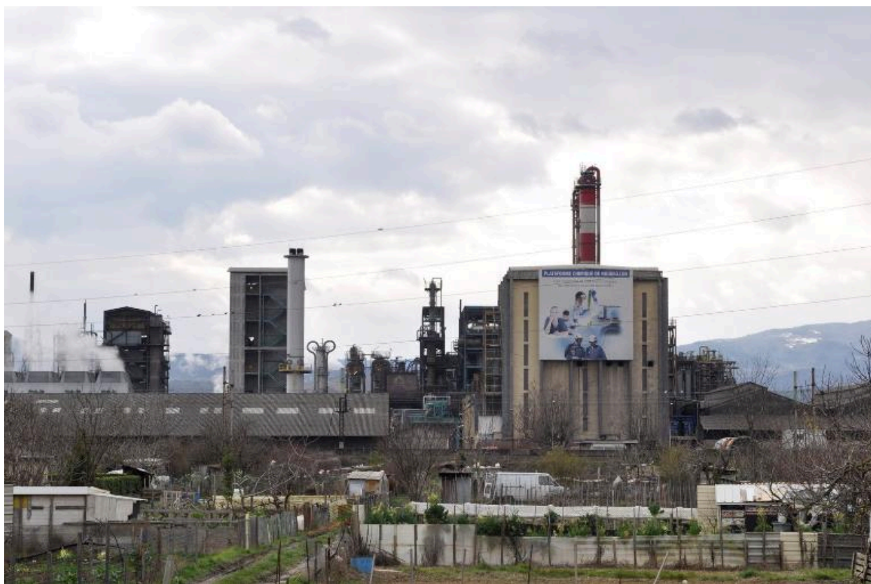
Vue d'ensemble de l'usine
