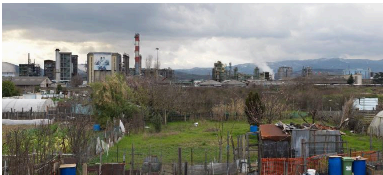
Vue d'ensemble de l'usine
