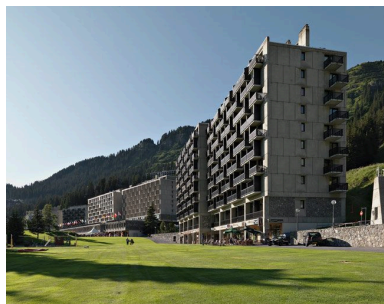
Vue de Flaine Forum depuis l'est Phot. Eric Dessert IVR82_20097400336NUCA
