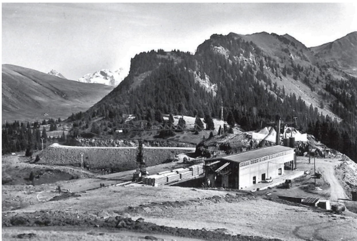
La gare supérieure de l'Arbaron, avec les stocks de préfabriqués à transporter vers le chantier (A. privées Berlottier)
