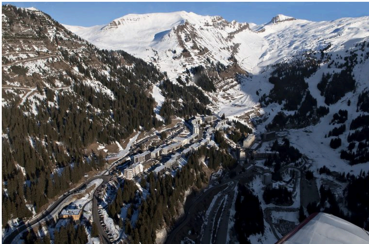
Vue aérienne de la stion depuis l'ouest
