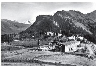
La gare supérieure de l'Arbaron, avec les stocks de préfabriqués à transporter vers le chantier (A. privées Berlottier) Phot. Jean-François Lyon-Caen IVR82_20127401570NUC
