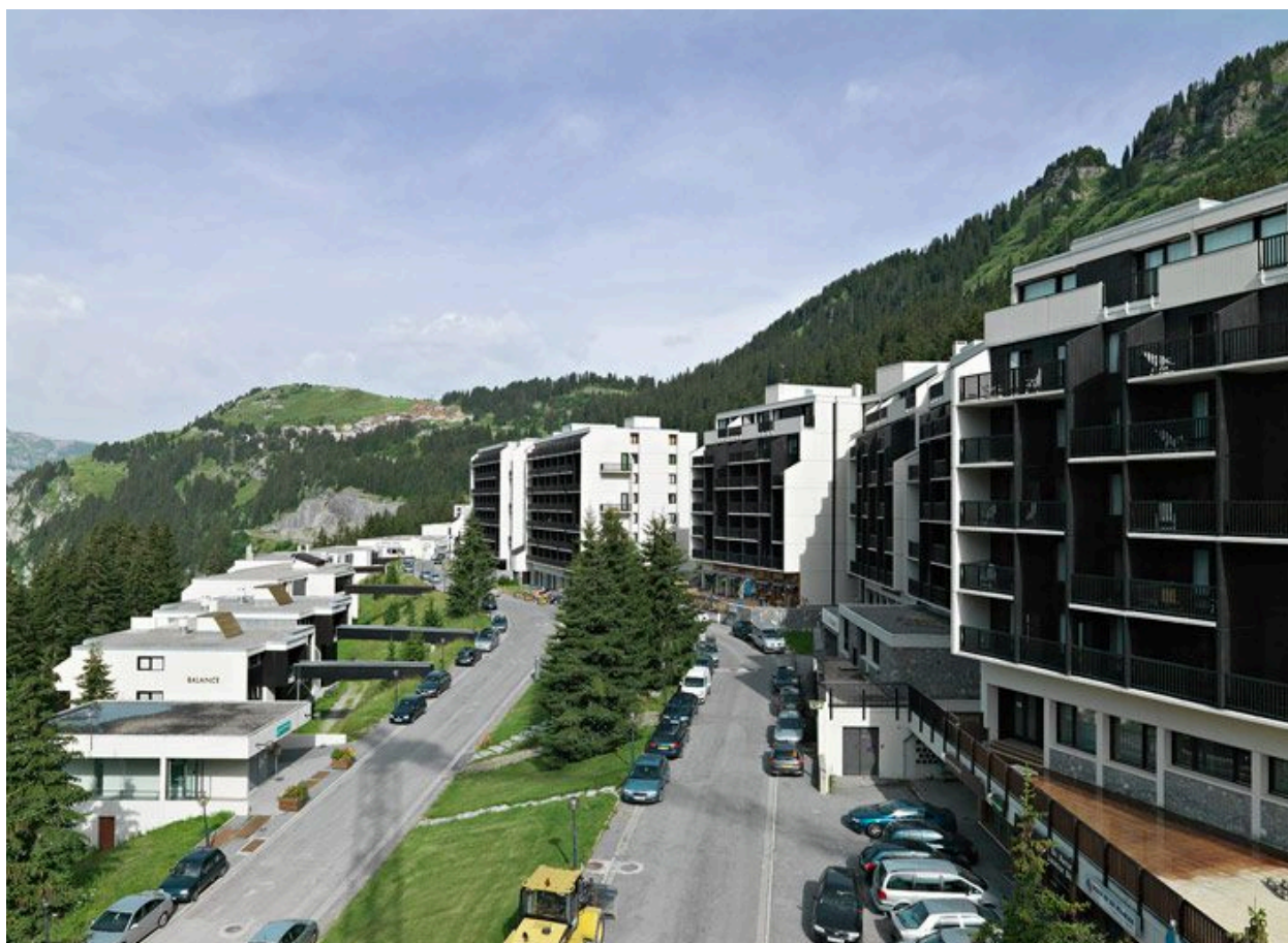
La rue de Flaine Forêt depuis l'est, à la hauteur de la résidence Balance
