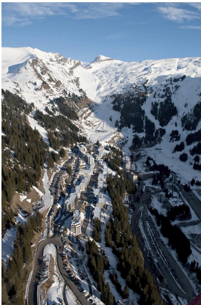
Vue aérienne de la station depuis l'ouest
