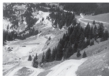
Les premiers terrassements à Flaine Forum, septembre 1962. En haut à droite, la piste de service (A. privées Berlottier) Phot. Jean-François Lyon-Caen IVR82_20127401566NUC
