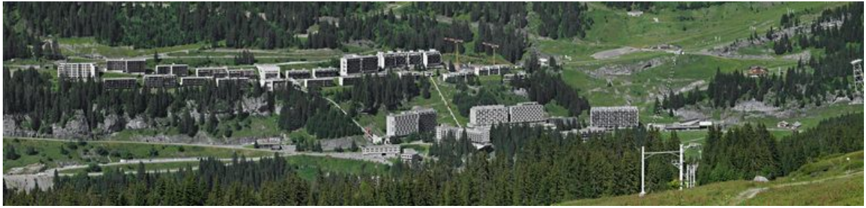
Vue d'ensemble depuis le sud-sud-ouest
