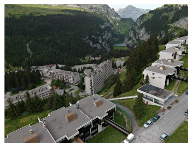
Vue de la station vers l'ouest, depuis Flaine Forêt Phot. Eric Dessert IVR82_20097400393NUCA
