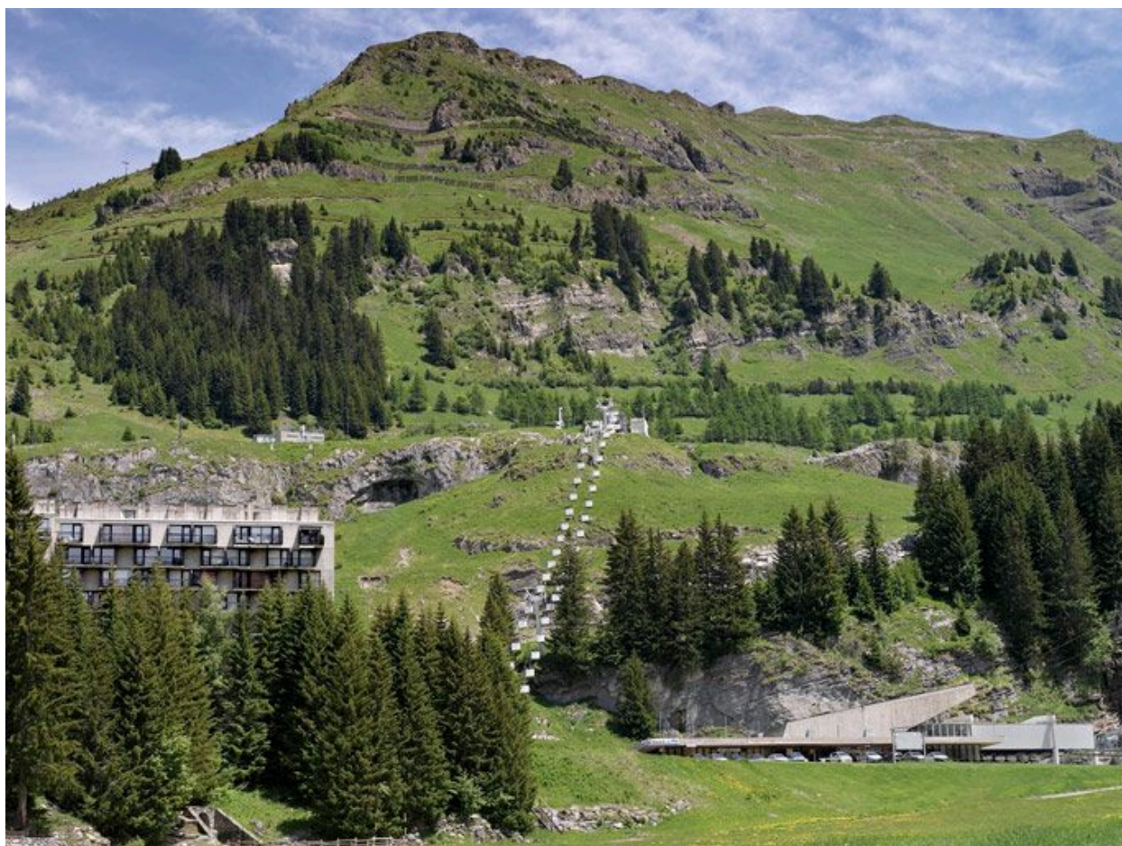
Vue vers les Grands Vans, la télécabine, et au 1er plan la gare du téléphérique des Grandes Platières
