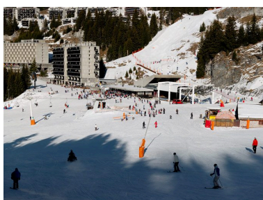
Vue depuis le sud-est, la grenouillère de Flaine Forum et la gare inférieure du téléphérique des Grandes Platières Phot. Eric Dessert IVR82_20107401921NUCA
