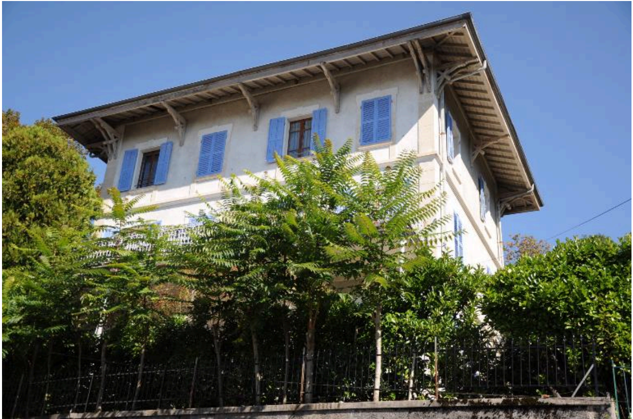
Vue de trois-quart depuis l'ouest
