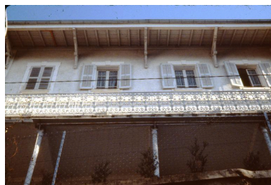
Détail sur le garde- corps et les colonnettes en fonte de la terrasse, 1983 Repro. Denys Harreau IVR82_20147301115NUCB
