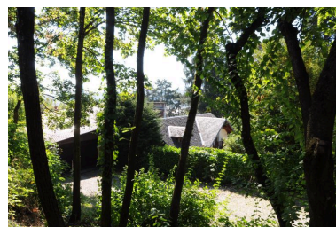
Aperçu sur le bâtiment annexe en limite sud-est de la propriété Phot. Denys Harreau IVR82_20137300967NUCA
