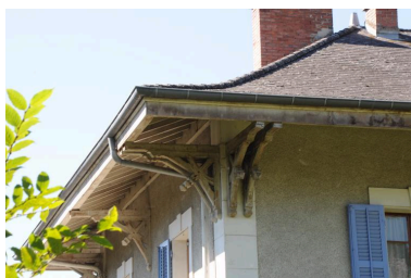
Détail sur les aisseliers en bois, angle sud-est Phot. Denys Harreau IVR82_20137300966NUCA
