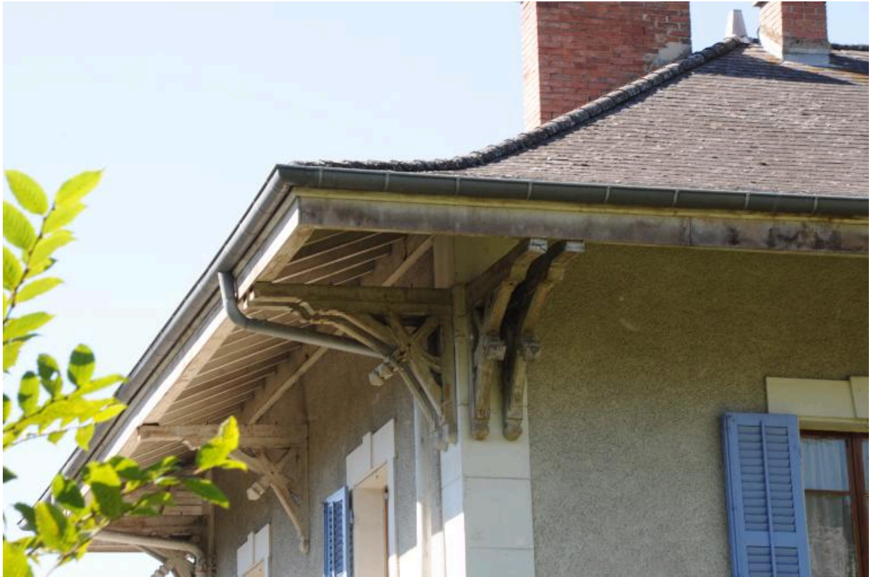
Détail sur les aisseliers en bois, angle sud-est
