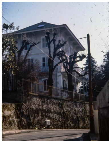
Vue d'ensemble depuis le nord-ouest, 1983 Repro. Denys Harreau IVR82_20147301114NUCB
