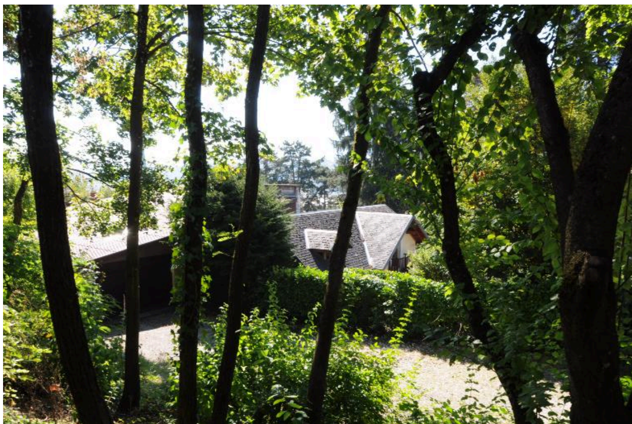
Aperçu sur le bâtiment annexe en limite sud-est de la propriété
