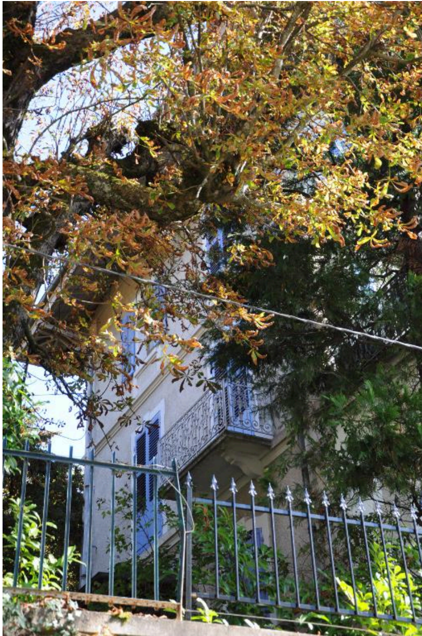
Aperçu sur l'élévation latérale nord
