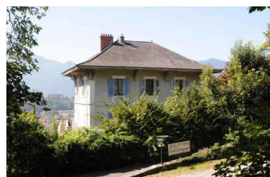
Vue de trois-quart depuis l'est Phot. Denys Harreau IVR82_20137300965NUCA
