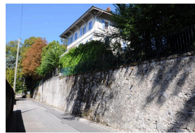
Vue générale depuis le boulevard Périn, prise depuis le sud Phot. Denys Harreau IVR82_20137300964NUCA
