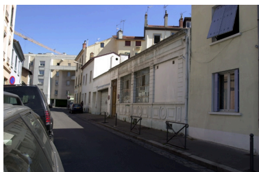
Vue générale sud-est Phot. Nadine Halitim-Dubois IVR82_20046902682NUCA
