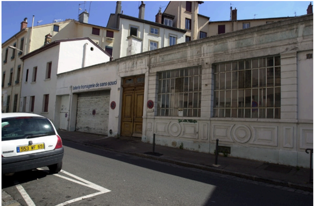
Vue d'ensemble ouest
