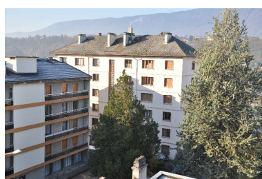
Vue d'ensemble Phot. François Fouger IVR82_20127300221NUCA
